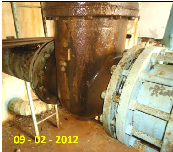
Photo 3-9 : Vanne papillon (station de pompage SP4).
