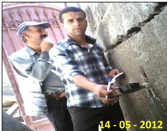
Photo3-16 : Mesure des pressions à l'aide d'un manomètre.
