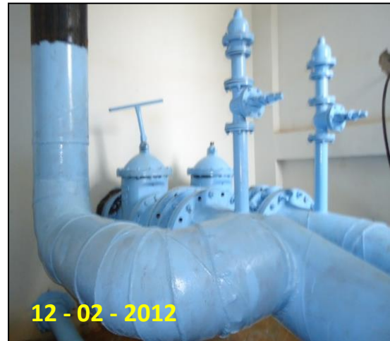
Photo 3-10 : Conduite de sortie du réservoir Mansourah 5000 m 3 .
