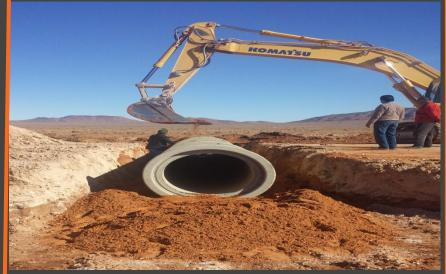
Mise en place des buses en béton armé Ø1000 mm.
