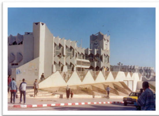
Figure 2.8: La nouvelle gare
