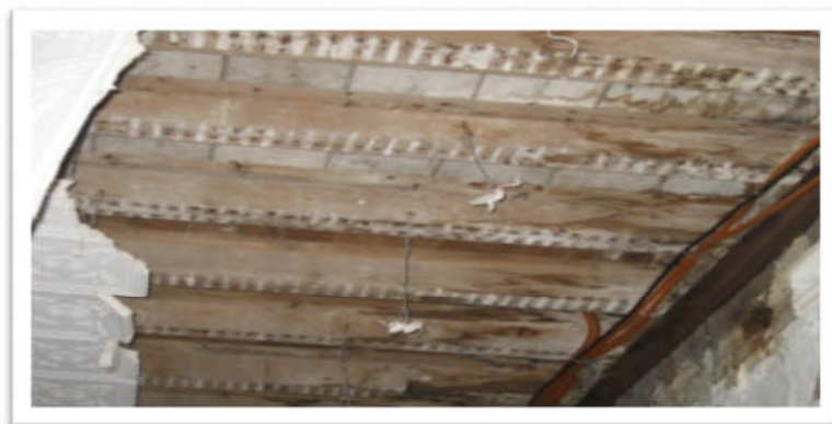
Figure 2 .21 : Plancher en bois (1)
