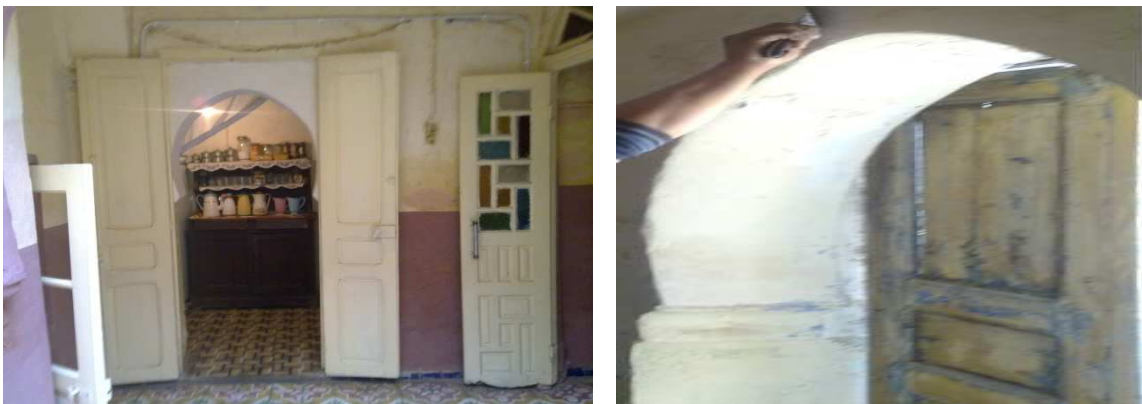
Figure 2.5 : Arc plein centre outrepassé
