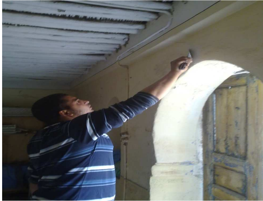
Figure 3.1: Mise en place des plaques témoins
