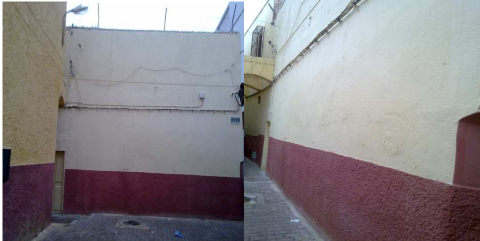
Figure 2.1 : Façade de cette maison
