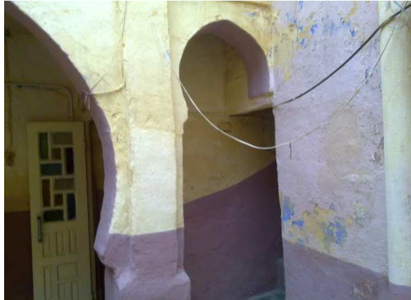
Figure 2.4 : Arc ogival outrepassé
