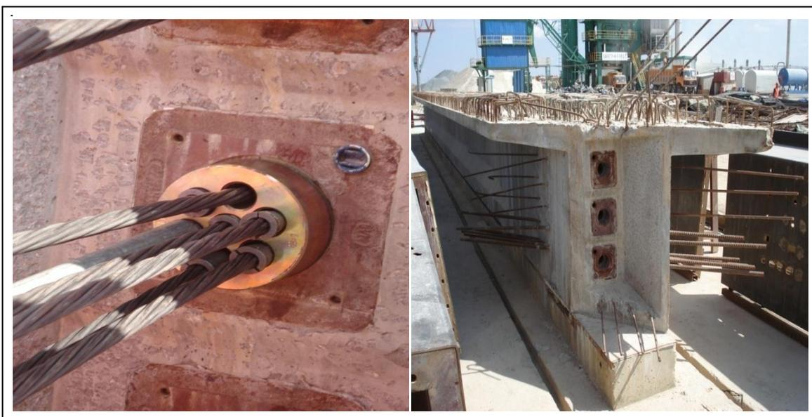
**Fig.5.1: Poutre en béton précontrainte**
