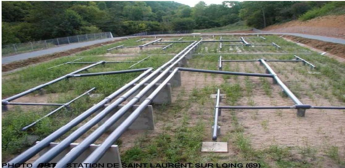
Figure III.6 Alimentation en surface des filtres verticaux de la station Saint Laurent (France) [68].
