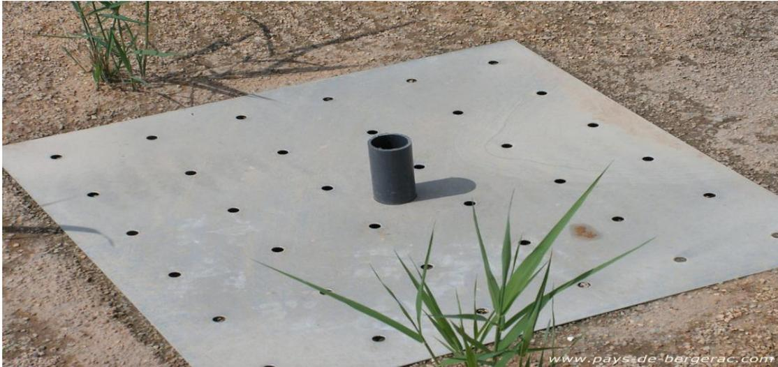
Figure III.7 Plaque anti-affouillement avec alimentation souterraine des filtres verticaux de la station d'épuration de Mauzac et Grant Castang [68].
