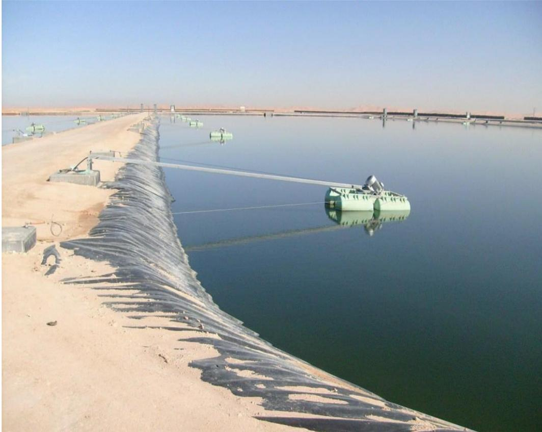
**Figure II.10** .Station de lagunage aéré de la ville d'Ouargla (Algérie) [36].
