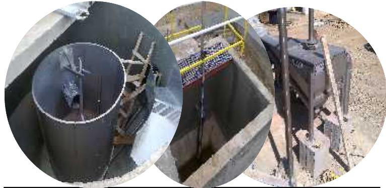
**Figure III.12 :** un déshuileur et un classificateur de sable de STEP BOUZEDJAR
