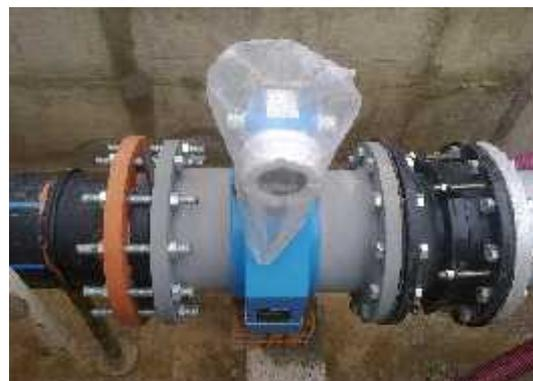
**Figure III.10** : Un débitmètre à l'entrée de STEP BOUZEDJAR
