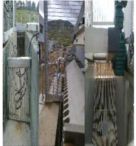
**Figure III.11 :**Un dégrilleur courbe et grille de secours de STEP BOUZEDJAR
