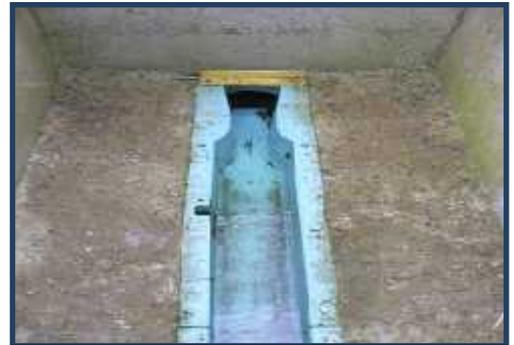
**Figure III.20** : canal venturi de STEP BOUZEDJAR
