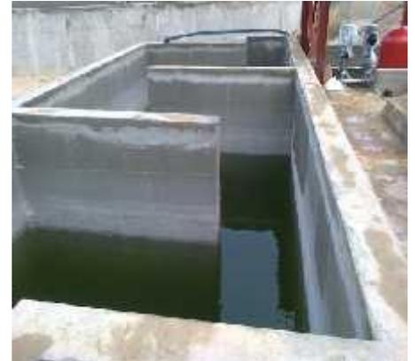
Figure III.18 : ouvrage pour l'injection de l'eau de javel de STEP
