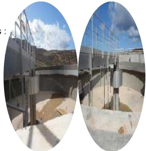
**Figure III.17** : un clarificateur de STEP BOUZEDJAR
