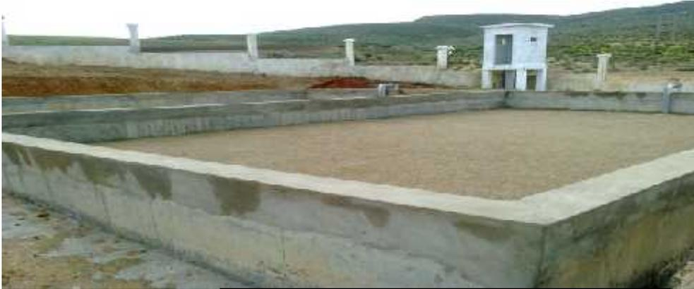
**Figure III.25** : lits de séchage de STEP de BOUZEDJAR
