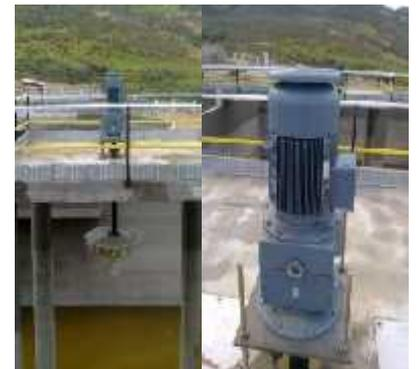
**Figure III.15** : les aérateurs de STEP BOUZEDJAR
