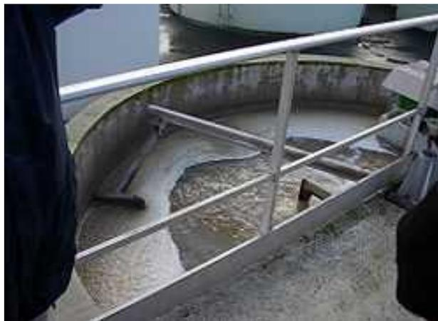
**Figure I.4: Déshuilage par écumage des graisses [18].**
