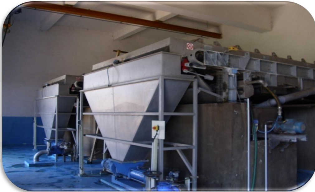
Figure III.11. Filtre à bande
