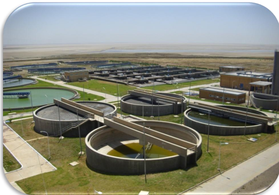
Figure III.7. Épaississement gravitaire
