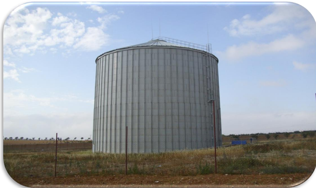
Figure III.12 gazomètre
