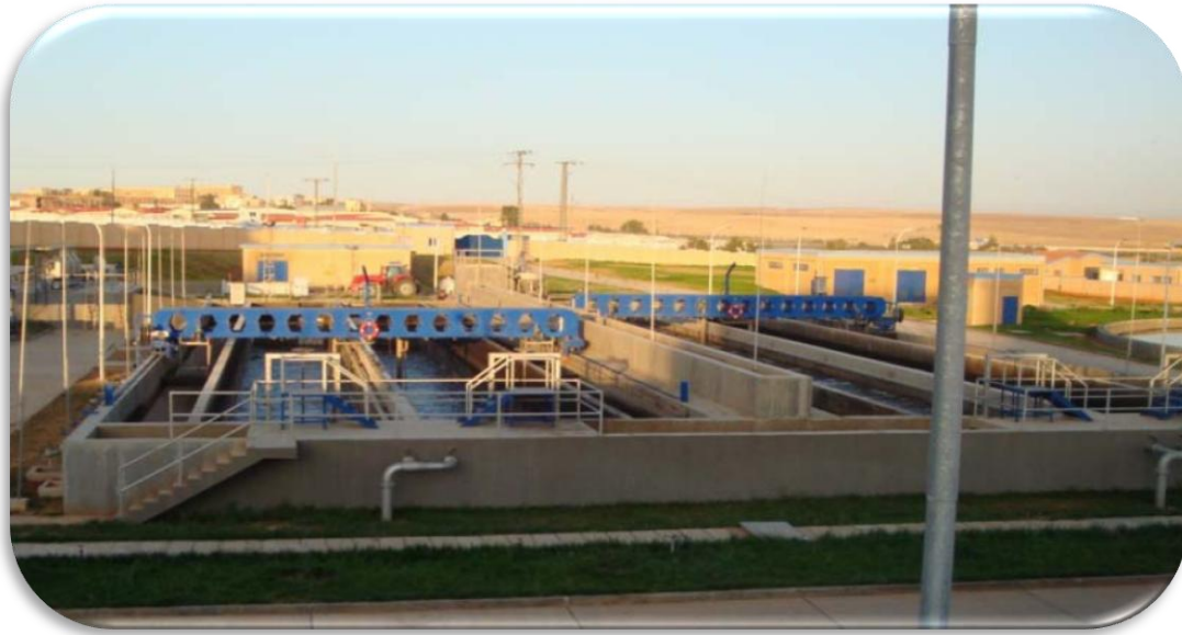
Figure III.3. Dessablage- déshuilage
