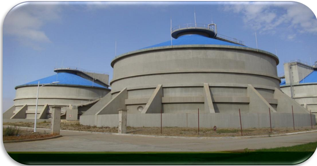
Figure III.9. Digesteur anaérobie
