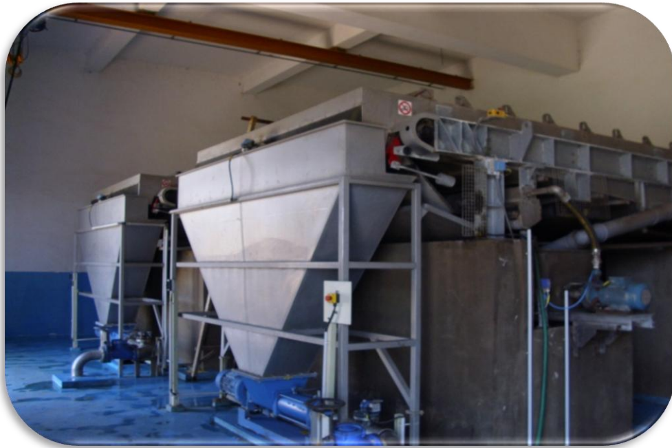
Figure III.8. Table d'égouttage
