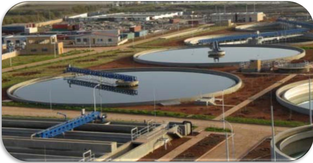
Figure III.4. Décanteur primaire
