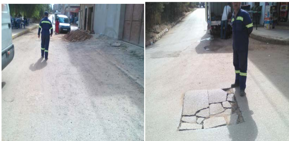
Figure III.7 : Absence de la pente sur le réseau de Ain Houtz à coté de la Poste.
