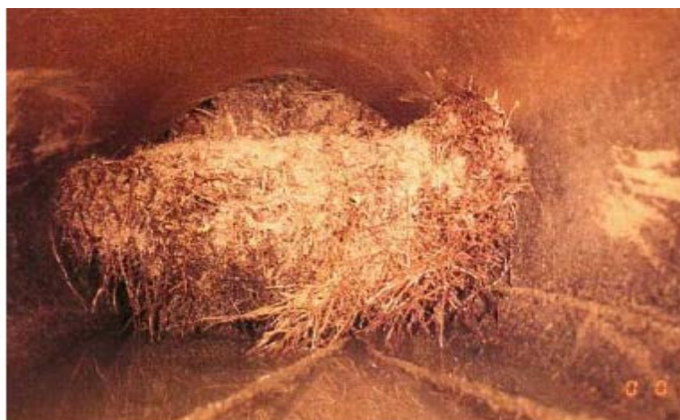
Figure II.4 : Exemple de blocage provoqué par la présence de racines [15].
