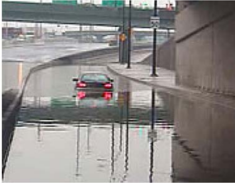
Figure II.1 : Inondation d'une autoroute en raison d'un manque de capacité de l'égout.
