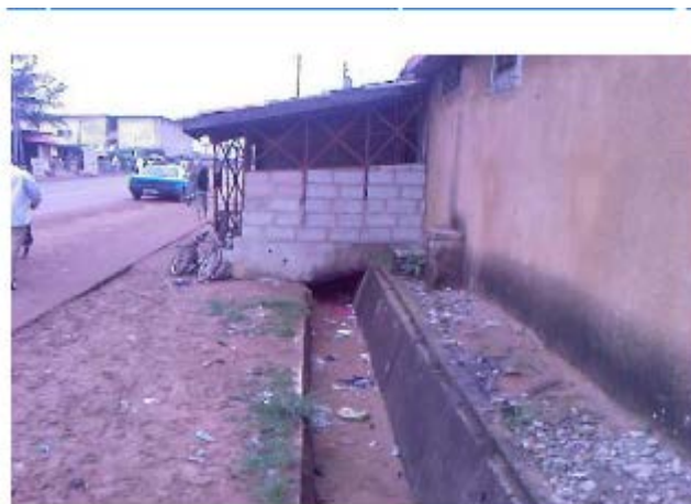
Figure III.12 : Construction sur un caniveau.
