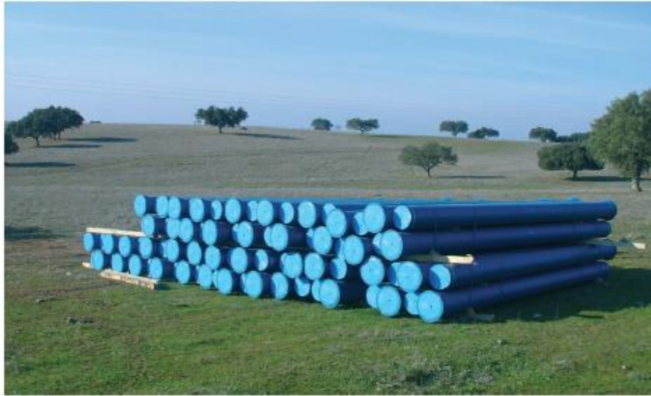
Photo. I.1 Stockage des tuyaux en fonte ductile
