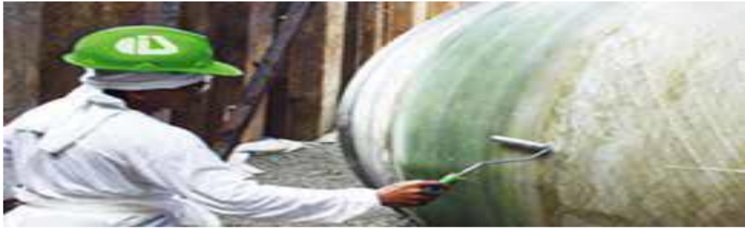
Photo I.8: Application du joint laminé pour conduites PRV
