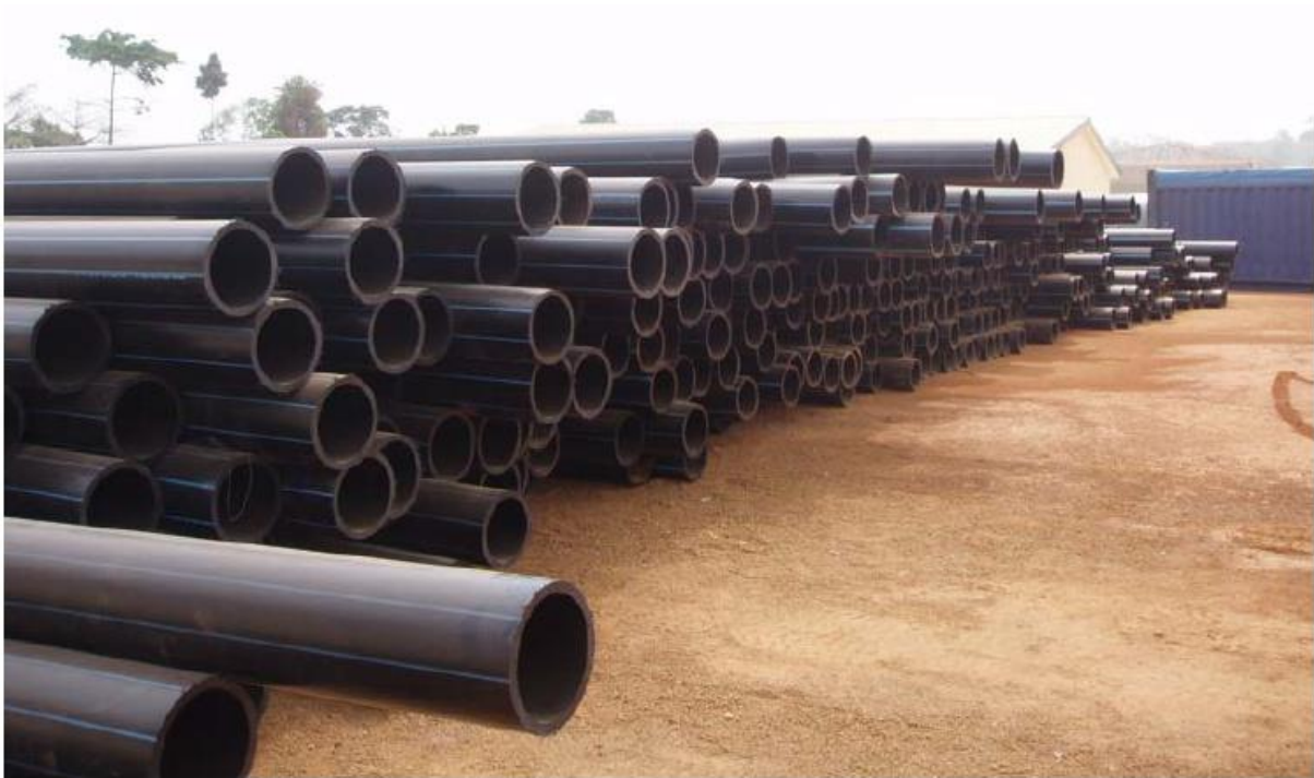
Photo I.4. Aire de stockage pour de canalisations en PEHD
