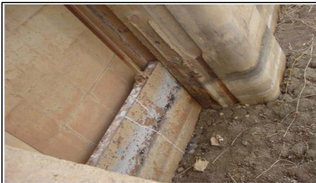
Photo.I.6. Blocage des vannes de fond (Remini, 2011)
