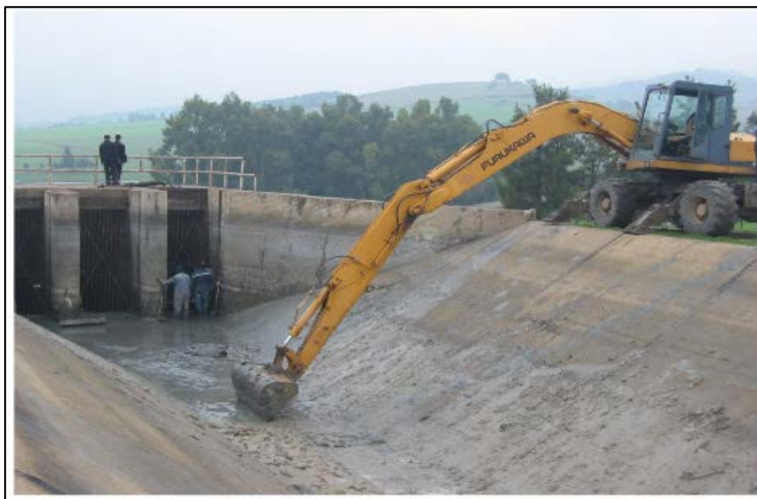
Photo. I.7. Curage d'un canal par les moyens mécaniques (OPIM, 2008).
