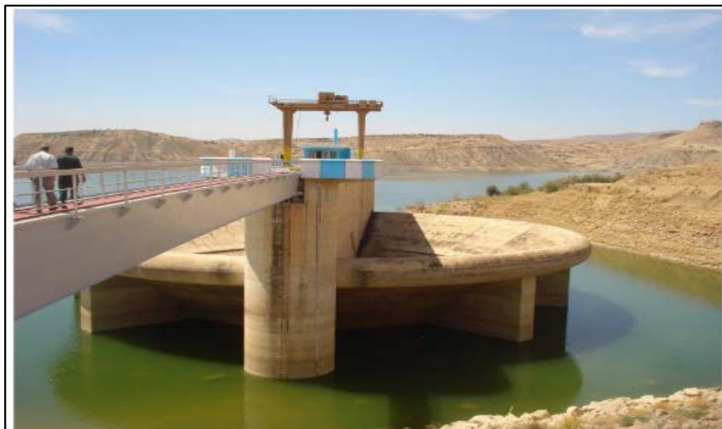
Photo. I.8. Couleur verdâtre de l'eau du barrage de SMBA (Remini, 2011)
