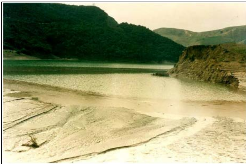
Photo. I.5. Envasement du barrage d'Ighil Emda (Remini et Ouaret, 2004)
