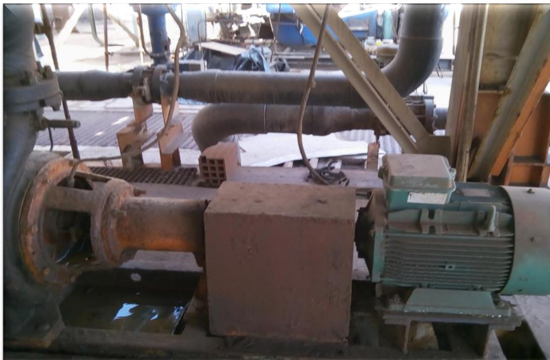
**Figure III.19:**Pompe centrifuge d'eau saumure
