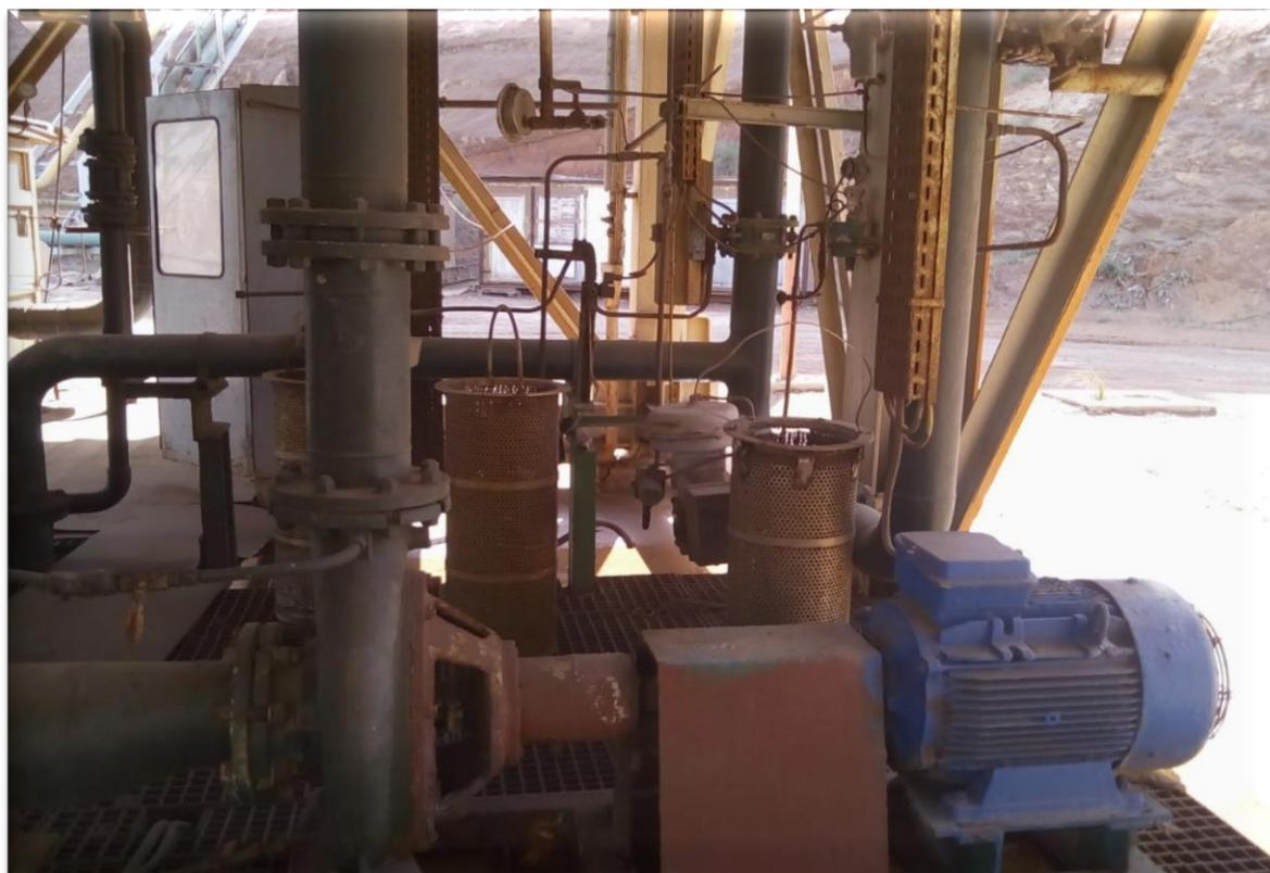
**Figure III.20:** Pompe centrifuge d'eau distillée
