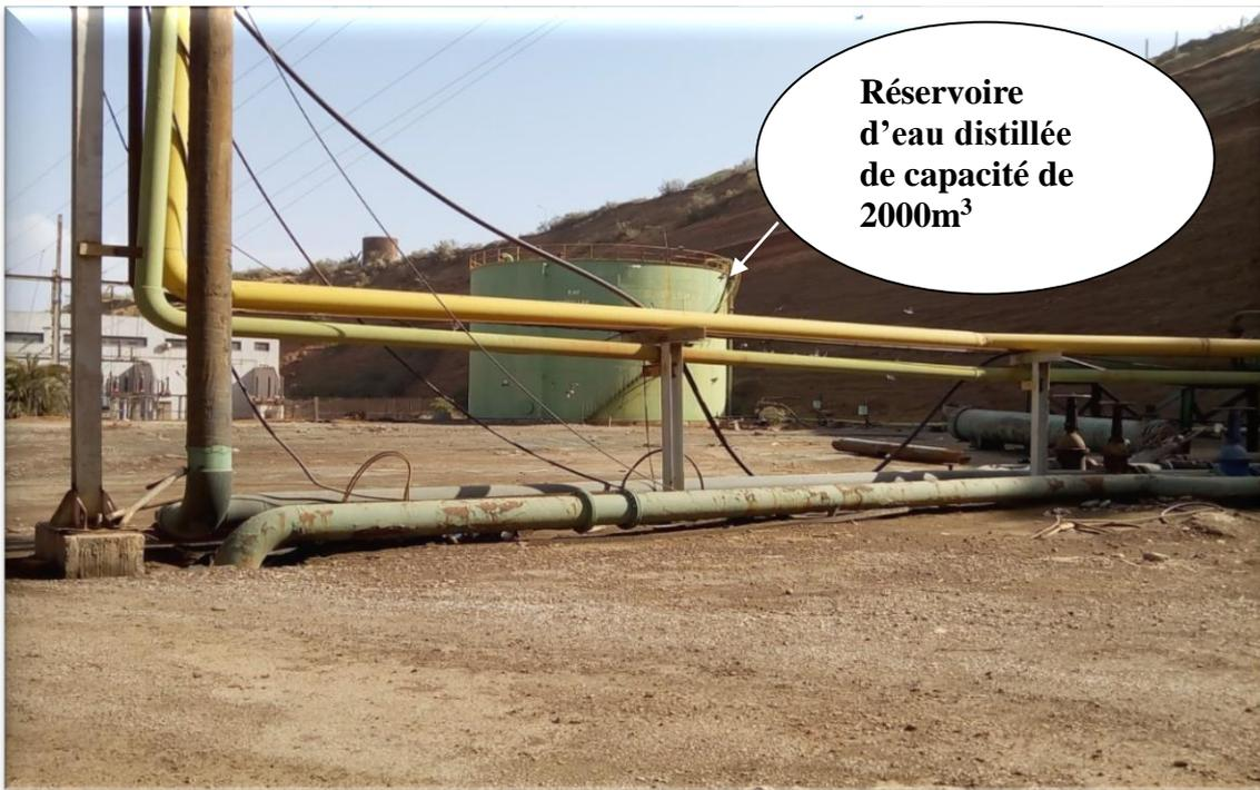
Figure III.26: Stockage de l'eau distillée
