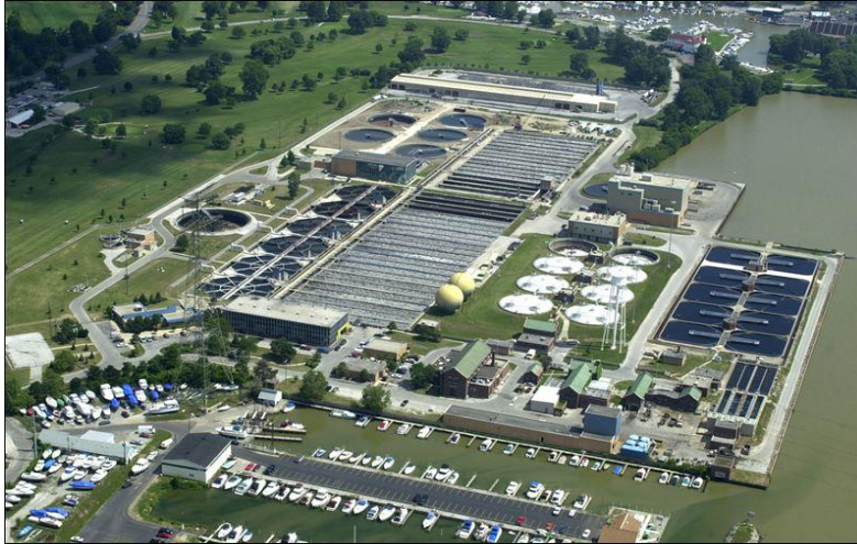
Figure I.1: exemple d'une station d'épuration de type Boues Activées (Toledo, 2017)
