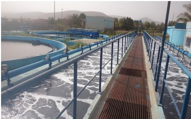
Figure III.28 : la STEP de l'unité E.A.T.I.T (Entreprise Algérienne Technologique Industriel)
