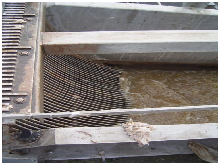
Figure II.2 : Lamelles de dégrillage [29]
