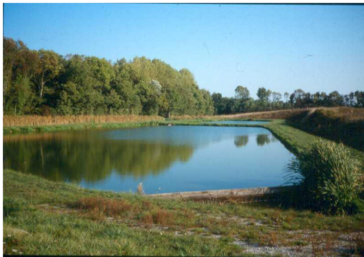
FigureII.7 : Photo d'un bassin de lagunage [46]
