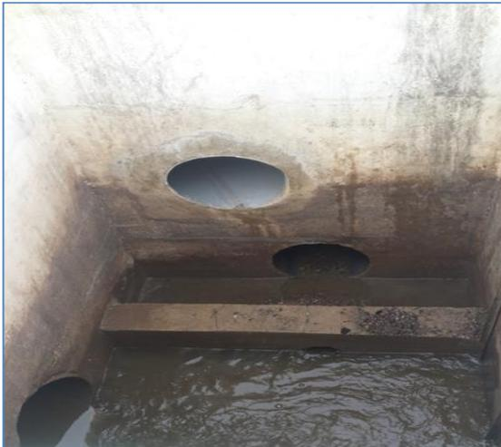
**Figure III.3:** Photo de bassin d'entrée (déversoir).
