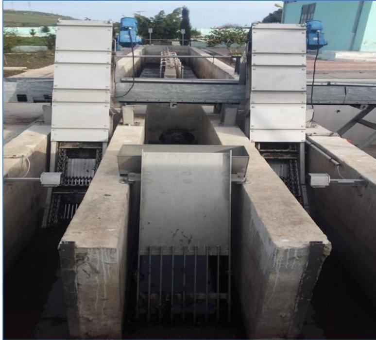
**Figure III.5 :** Photo de Dégrilleur.
