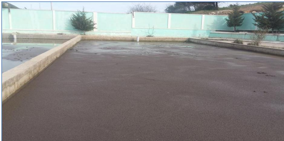
**Figure III.17 :** Photo de lit de séchage.
