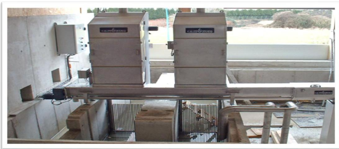
**Figure I.2 :** Photo d'un dégrilleur automatique vertical [41].
