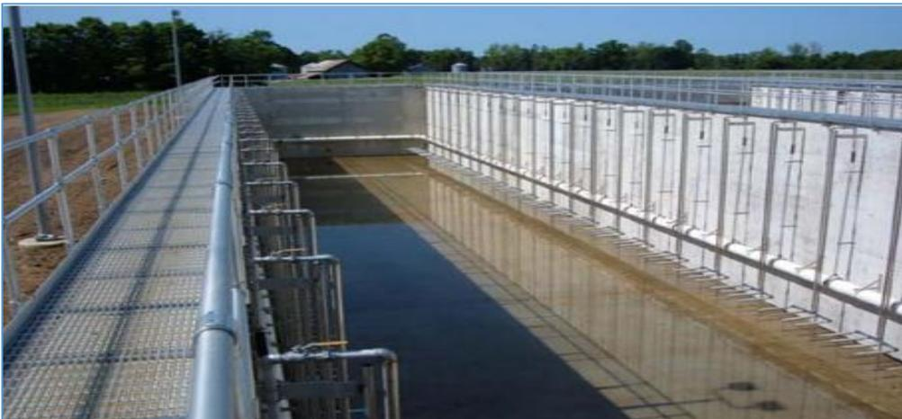
**Figure II.6 :** Bassin d'aération primaire technologie SEQUOX [77].
