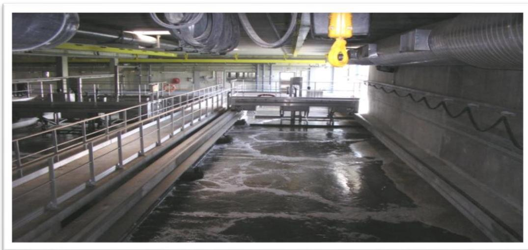
**Figure I.4 :** Photo d'un bassin de dessablage – dégraissage [45].
