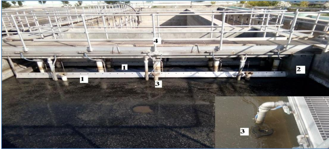
**Figure III.13 :** Photo de clarificateur ClarActor.
