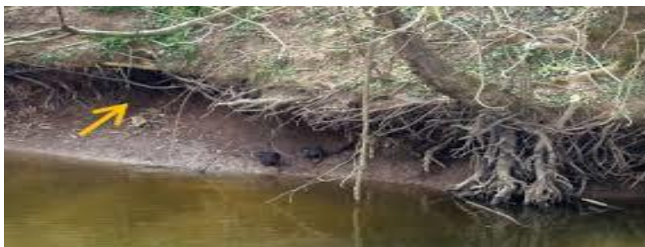
Photo I.1 : Erosion des berges [1]
