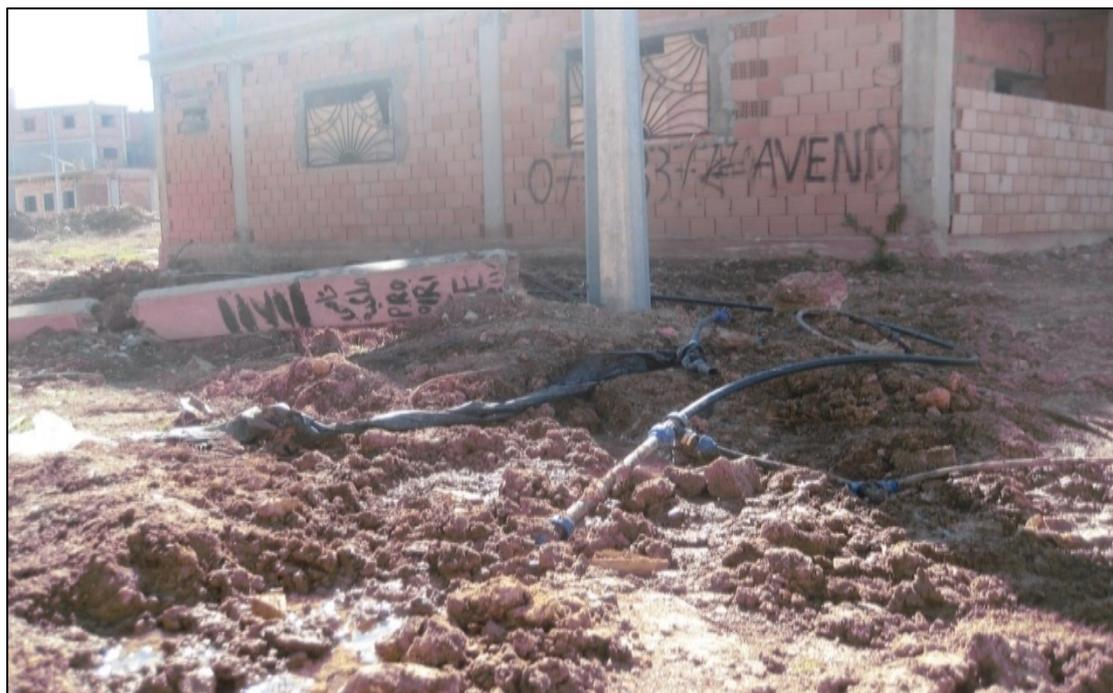
**Figure3. 13 Les Branchements illicites à 500 logements Bouhanak (photo Benladghem Z, 2017)**
