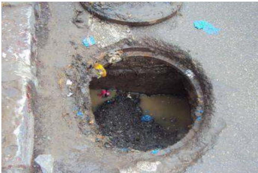
**Figure 2.40 Arrivée massive des sables et autres corps solides qui obstruent les conduites (Sid Lakhdar A, 2012)**
