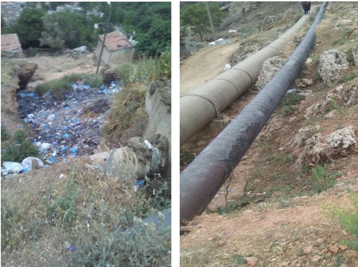
**Figure 3.26 Dechets des habitants sur la conduite d'adduction en eau potable(photo Benladghem Z 2017)**
