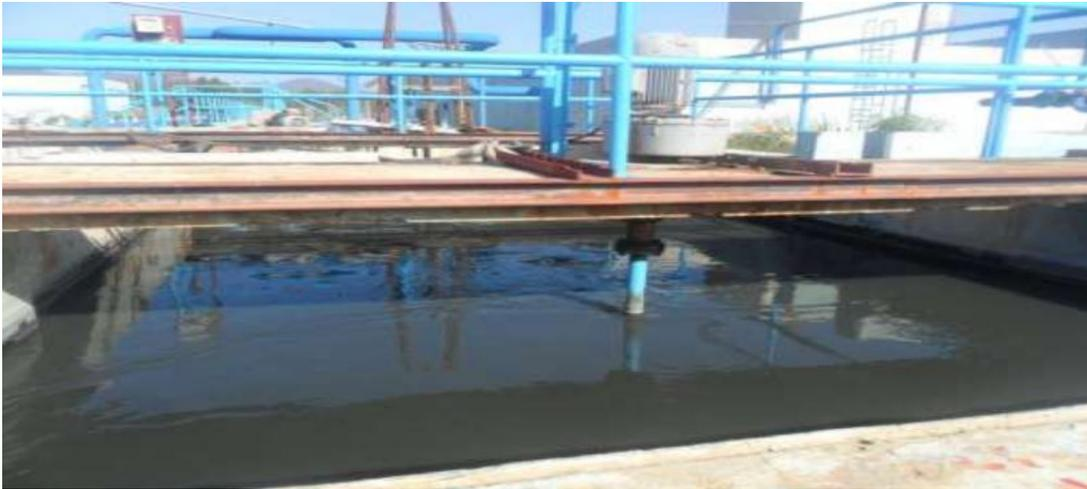
**Figure II.10: Photo du bassin de mélange et de neutralisation et d'égalisation N°2.**
