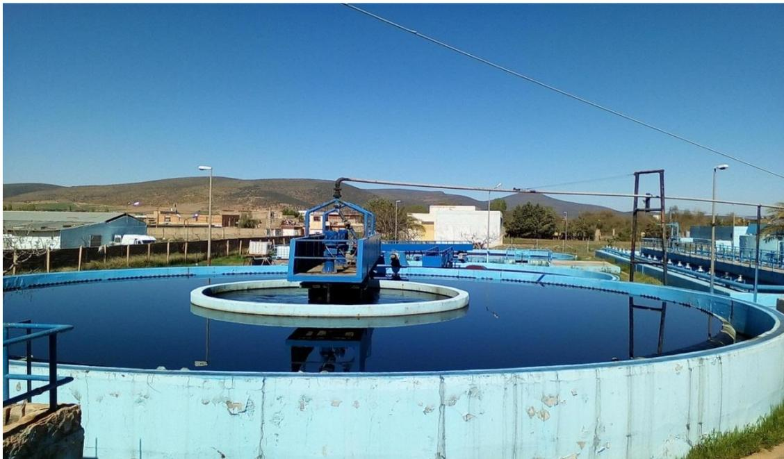
**Figure II.9 : Photo du flocculateur clarificateur.**
