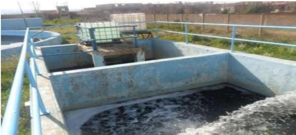
**Figure II.13 : Photo du bassin de post chloration**
