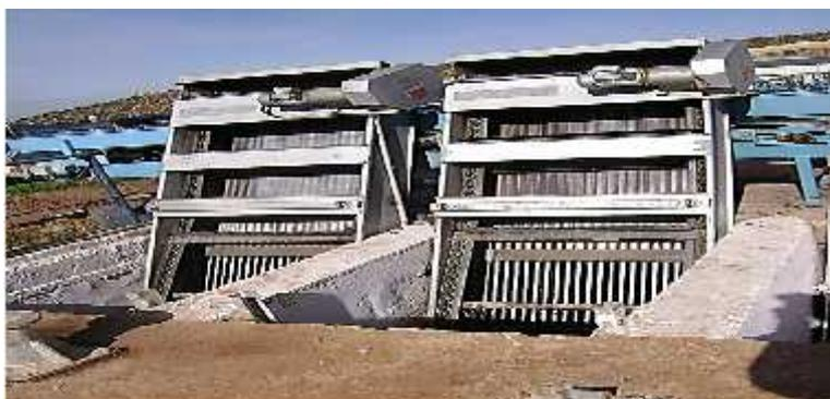
**Figure III.5 :** Grille mécanisée (2 unités)
