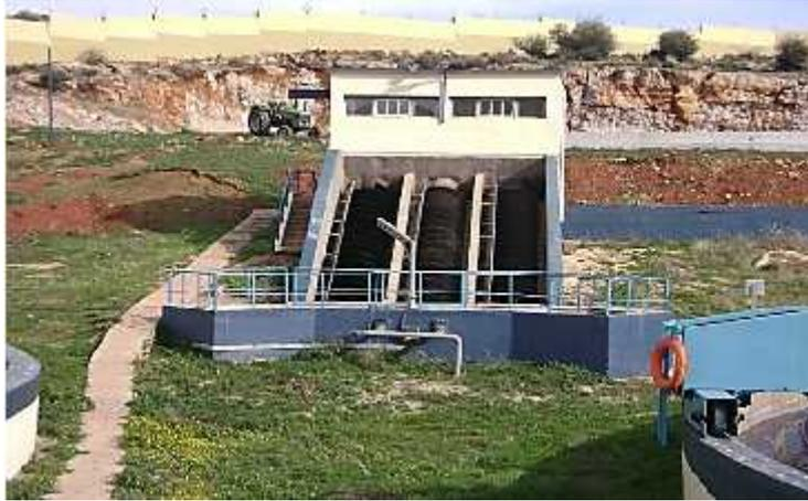
**Figure III.11** : Vis relevage des boues
