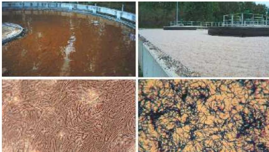
**Figure II.2** : Dysfonctionnements biologiques : voile de boues élevé dans un clarificateur dû à la prolifération de *Microthrix parvicella* (à gauche) et mousses stables en surface d'un bassin d'aération dues à la prolifération de *Mycolata* (à droite) [source : [www.cairn.info](http://www.cairn.info)]
