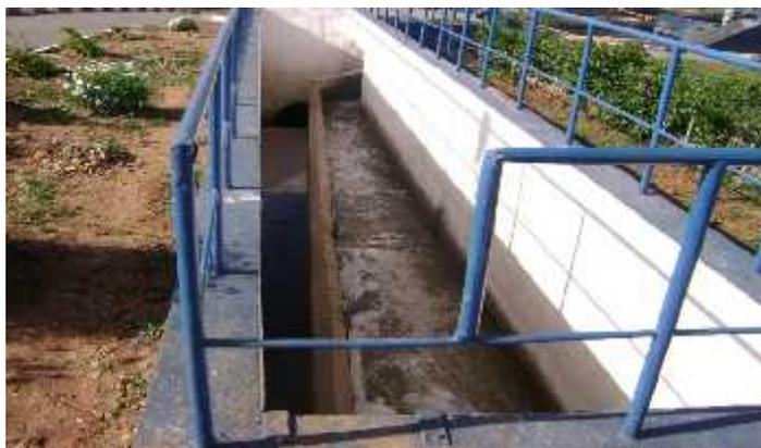
**Figure.III .3:** Photo Déversoir d'orage
