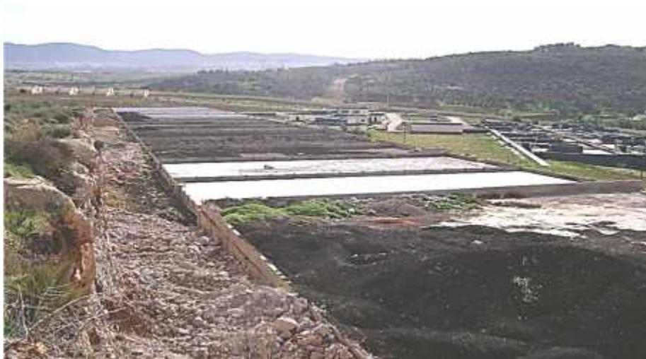
**Figure III.13** : Lits de séchage +Aire de stockage
