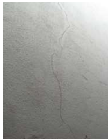
Photos 2.7. Des fissures verticales.
