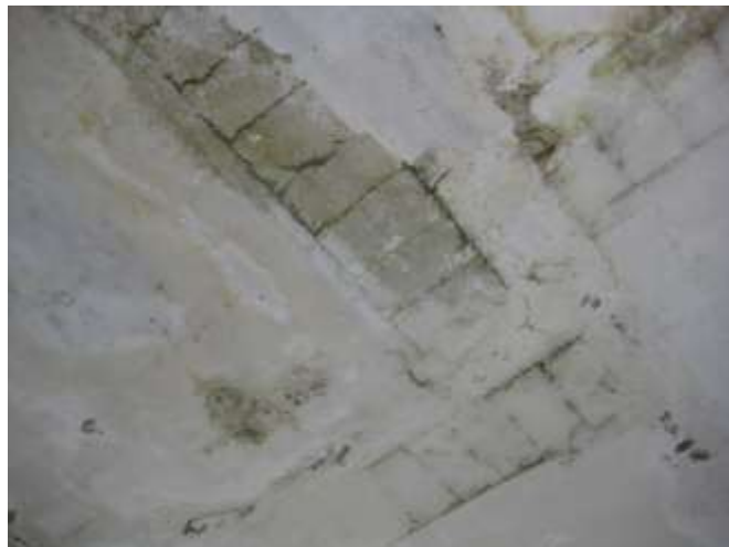
Photo 2.12. Deux poutres croisées, sans poteau.
