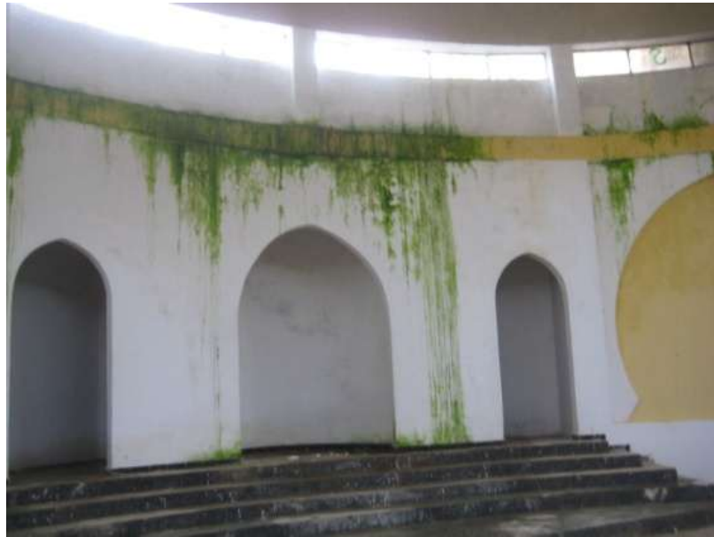
Photo 2.15. Un manque de poteau qui a été arraché pour dégager l'espace pour le mihrab.
