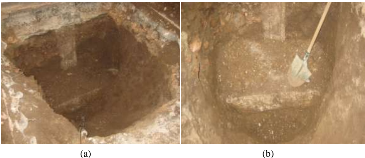
Photos 2.3. Semelle superficielle type isolée ancrée à une profondeur moyenne de 1m.
