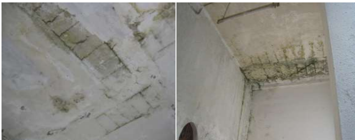
Photo 2.16. Les traces de ruissellements et d'infiltrations sur les murs.
