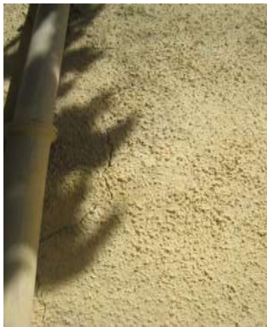
Photos 2.7. Des fissures verticales.
