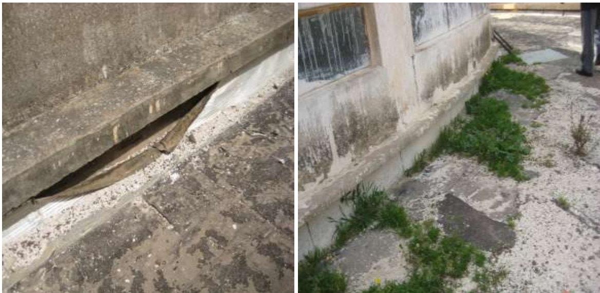
Photo 2.14. Dégradation du complexe d'étanchéité sur la terrasse plate.
