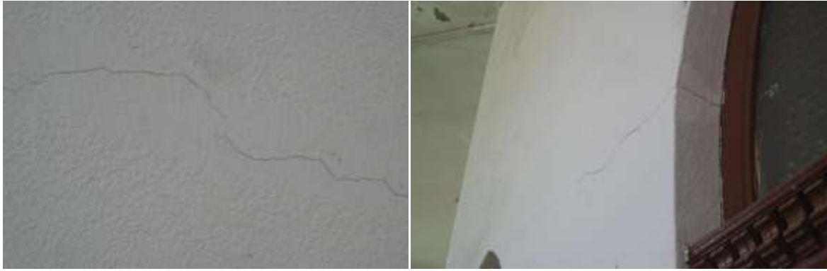
Photos 2.6. Des Fissures horizontales.
