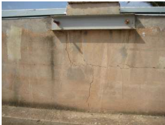
Photo 2.21. Déchirures des cordons de soudures réalisés aux droits de rabouillage des sections des profilés en U.
