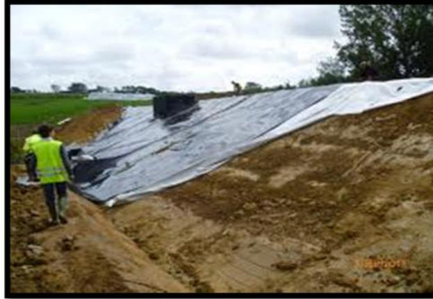
**Figure 2.7** Exemple d'utilisation de géomembrane (Briançon, 2001)
