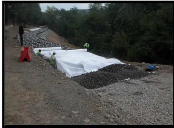
Figure 1.8 Renforcement par pneu sol
