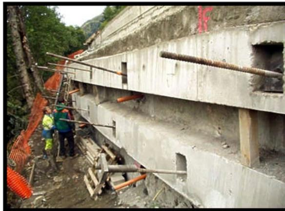
Figure 1.9 Renforcement par ancrage
