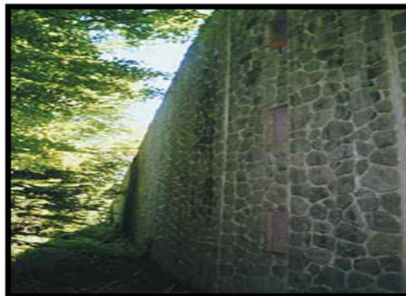
Figure 3.8 Ouvrage renforcé EBAL-LCPC l'Hospice de France-vue de parement. (LCPC, 2003)
