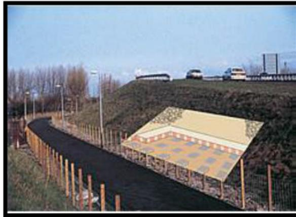
Figure 2.10 Vue d'un remblai reposant sur une plate-forme de transfert de charge. (MAMEN ; 2010)
