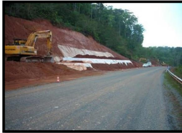
**Figure 1.7** Renforcement par géosynthétiques
