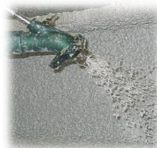
Fig.XII.3 Mises en œuvre d'enduit
