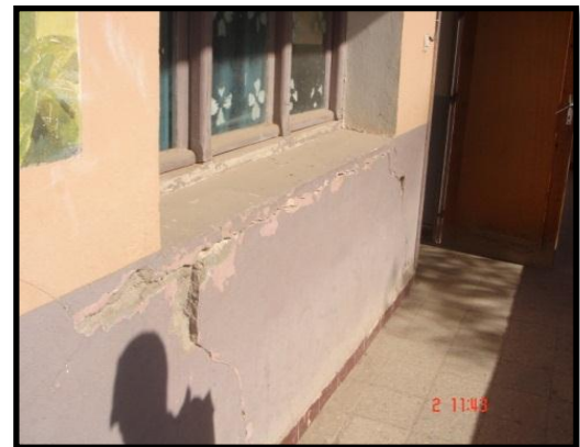
Figure 2.7. : Les fissures horizontales (École Ibn Baytar)
