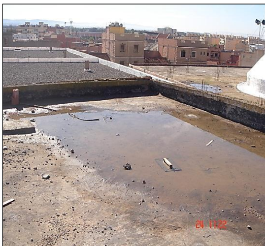
Figure 3.11. Problème de l'étanchéité à l'école Ibn Baytar
