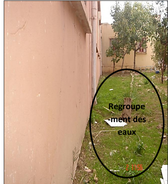
Figure 3.9. : Absence de trottoir et regroupement des eaux (Ecole Ibn Baytar)
