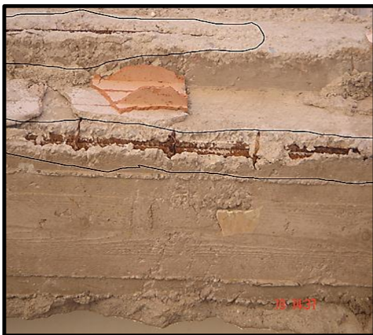
Figure 2.16. : La dégradation du béton (École Ibn Baytar)
