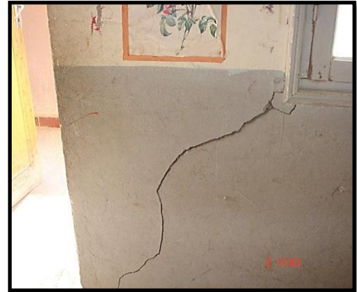
Figure 2.6. : Les fissures diagonales (École Ibn Baytar)
