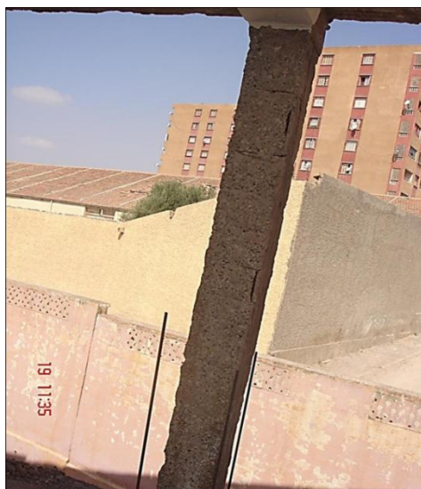
Figure 3.16 : Faible épaisseur de l'Enrobage (Ecole Ibn Baytar)
