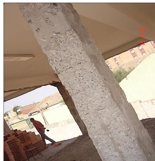
Figure 3.16 : Faible épaisseur de l'Enrobage (Ecole Ibn Baytar)
