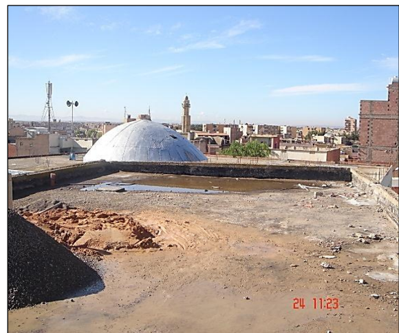
Figure 3.11. Problème de l'étanchéité à l'école Ibn Baytar
