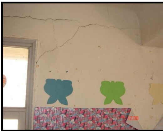
Figure 2.7. : Les fissures horizontales (École Ibn Baytar)
