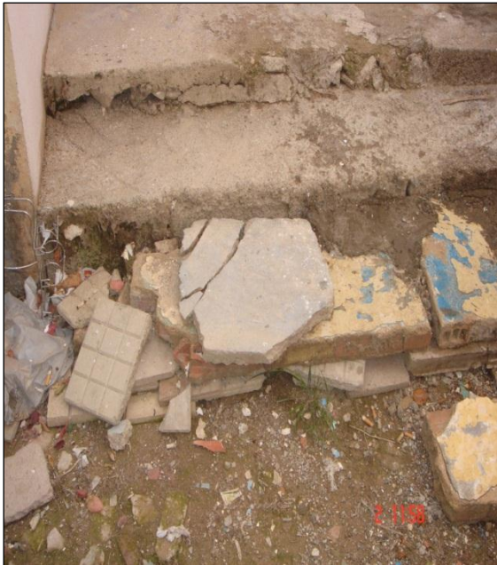
Figure 3.9. : Absence de trottoir et regroupement des eaux (Ecole Ibn Baytar)
