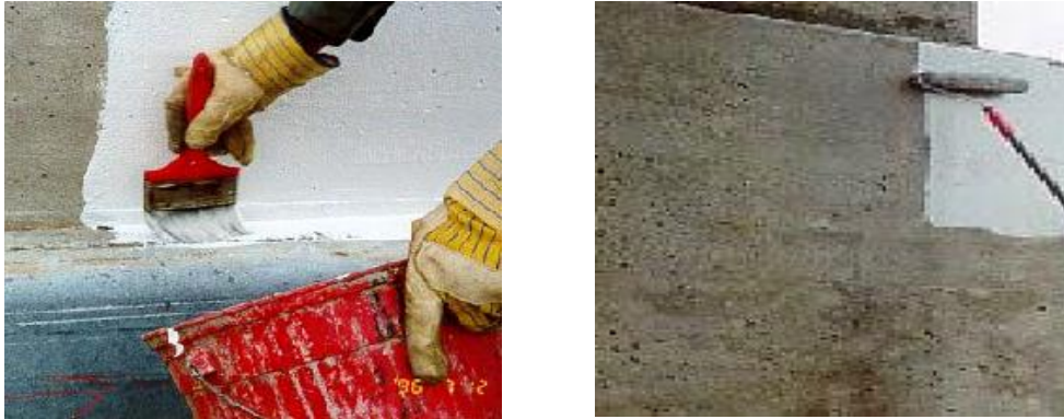
Figure 4.20. Application de peinture
