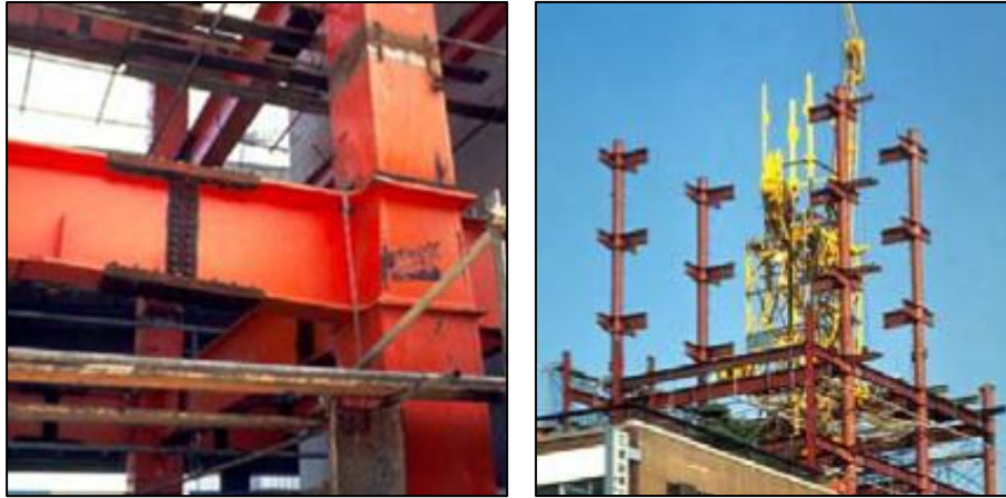
Figure II.11 : Assemblages métalliques des zones critiques.
