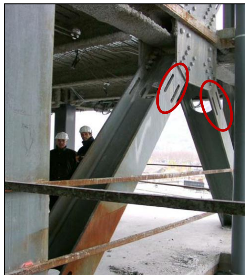
Figure II.8 : Chantier du palais de Justice de Grenoble 2000 Une zone « faible » a été organisée à l'extrémité de chaque barre de contreventement de manière à maîtriser l'emplacement d'une éventuelle rotule plastique, « zone dissipative »
