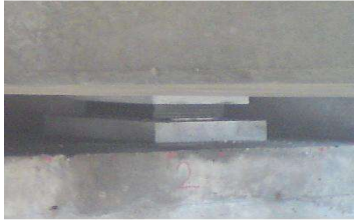
Figure 7.1 : Appareil d'appui en élastomère fretté.
