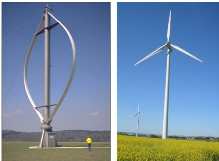
Figure 1.5 : Représentation des concepts d'éoliennes à axe horizontal (gauche) et à axe vertical (droite)
