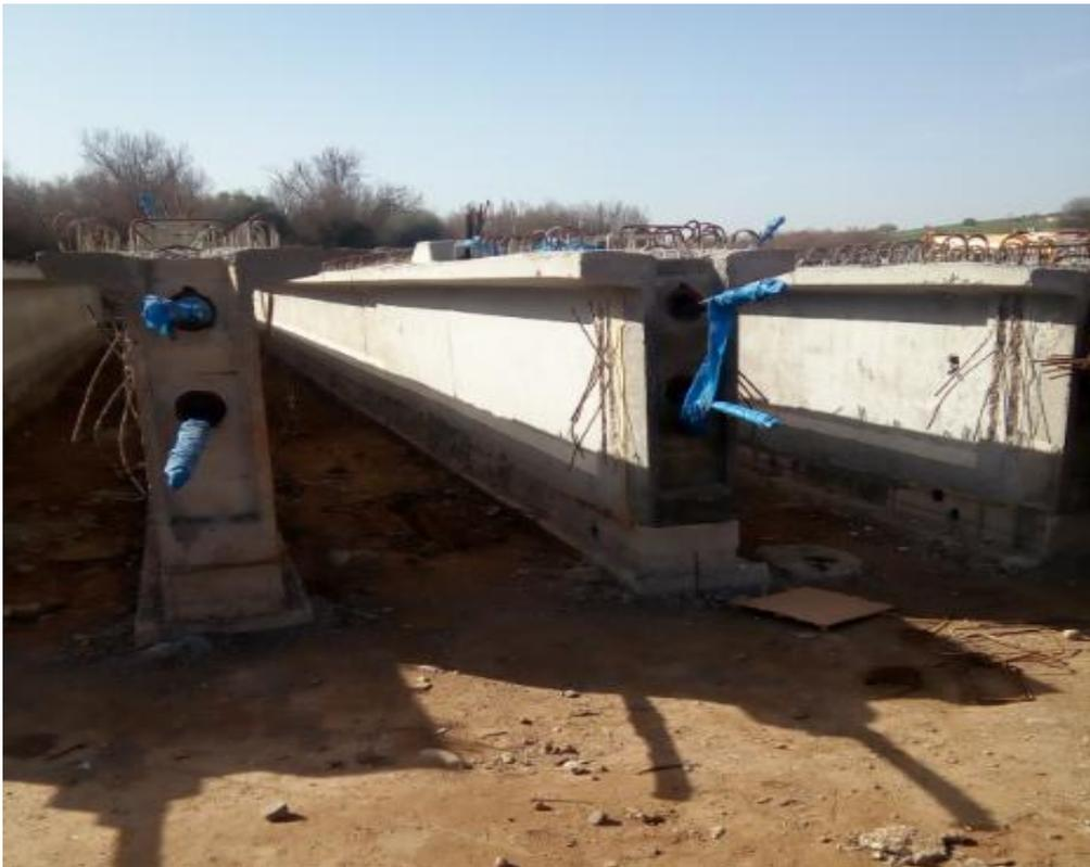
Figure3.8 : Les câble d'about sur chantier
