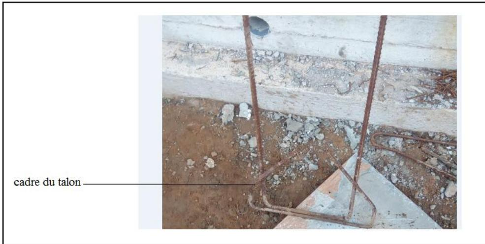
Figure 3.14 : Détail de ferrailage sur chantier
