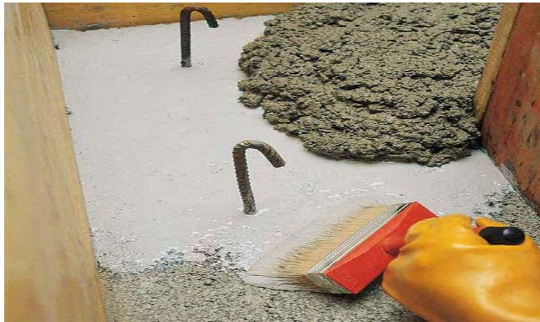
**Figure II.5: Coulage du béton avec le produit Sika.**
