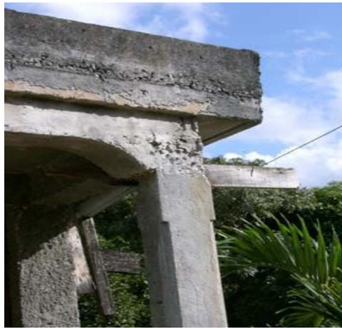
**Figure II.1 : Reprise de bétonnage poteau/poutre.**
