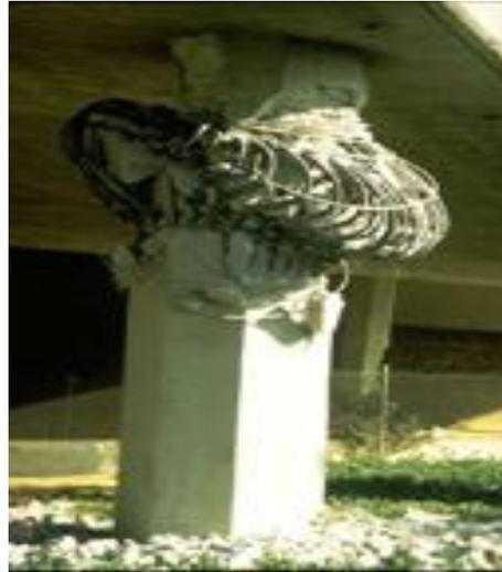
**Figure 1.16. Développement de rotules plastiques lors du séisme de Northridge (USA, 1994)**
