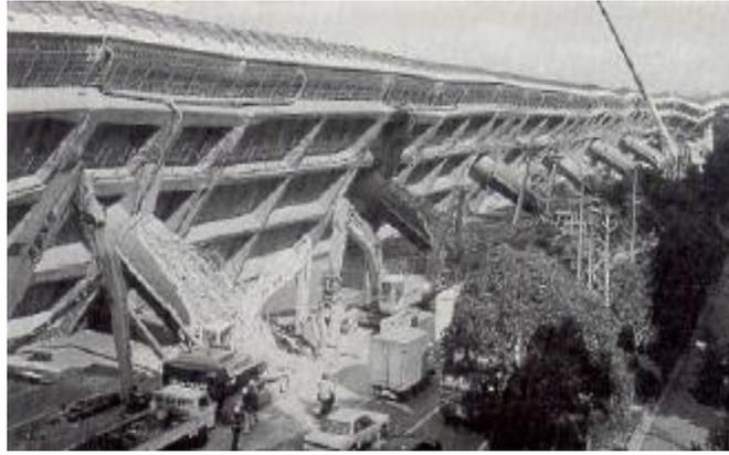
**Figure 1.15. Exemple de dommage d'un pont suite au séisme de Kobé (Japon 1995)**
