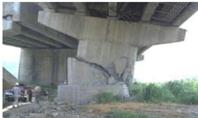
**Figure 1.17. Rupture par cisaillement d'un pile lors du séisme de Chi-Chi (Taiwan, 1999)**
