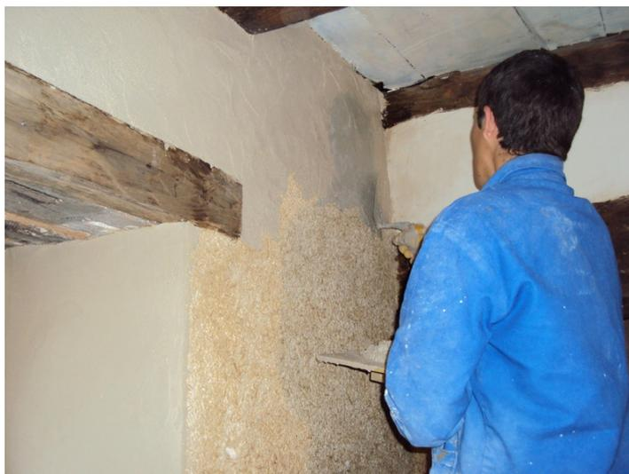
**Figure N43** : Photo : Initiation aux techniques d'enduits chaux-chanvre.
