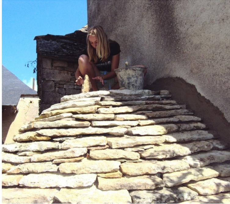
**Figure N45** : Photo : Pose de lauzes.
