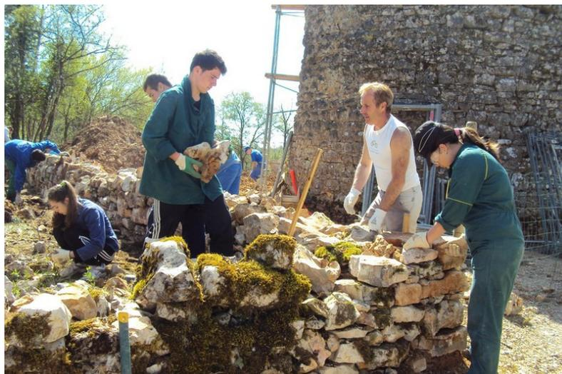
**Figure N41** : Photo : Technique de maçonnerie : Pierre sèche.
