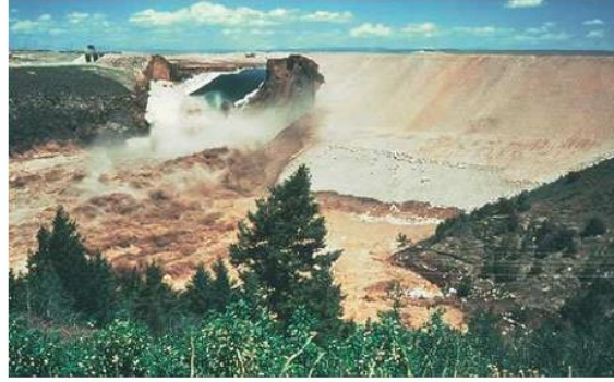
Rupture du barrage de Teton (USA).
