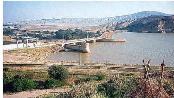
Le barrage de Fergoug après reconstruction 1986.
