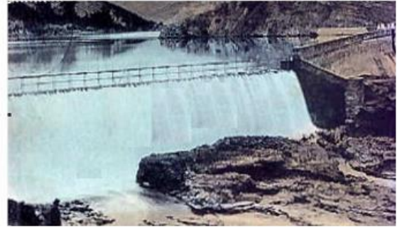
Le barrage de Fergoug en déversement.
