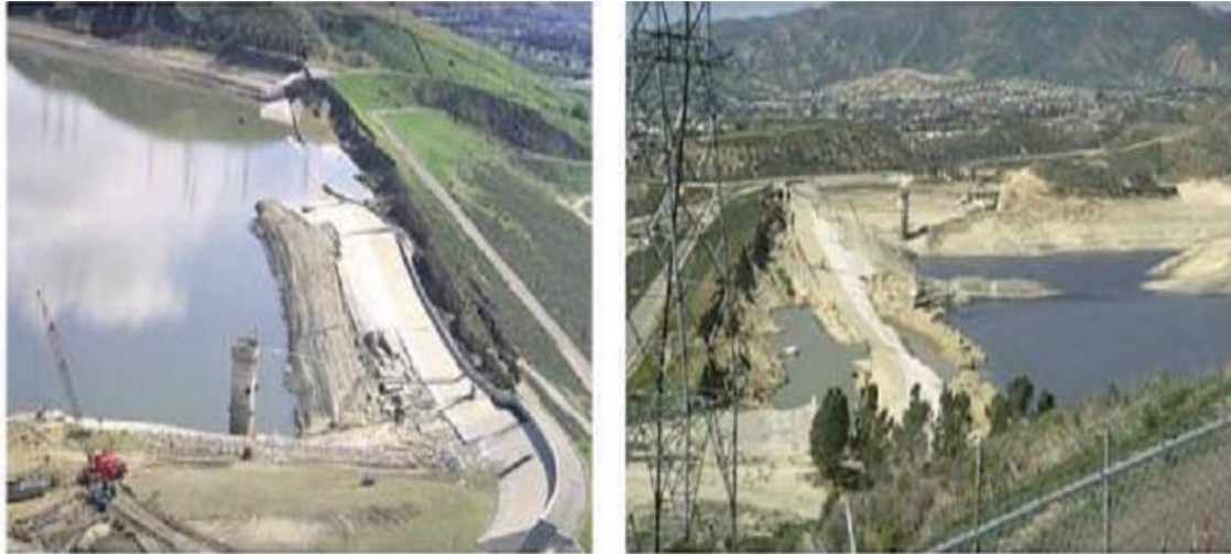
Figure 1.12 : Barrage de San Fernando [1]
