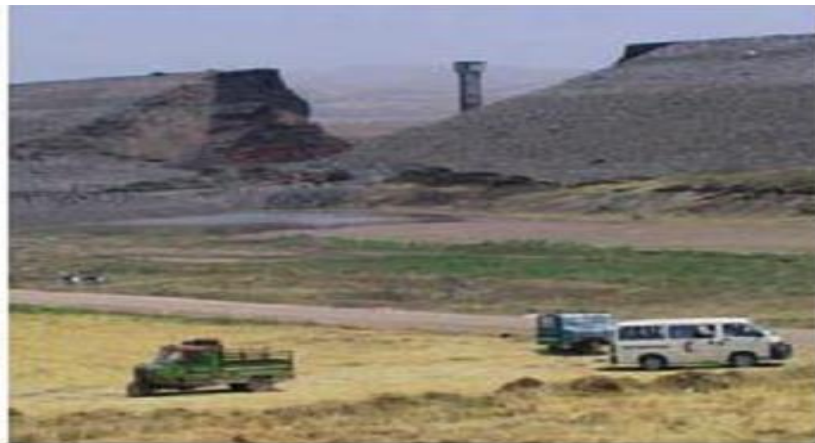
Figure 1.13 : Barrage de zeyzoun après sa rupture [1]
