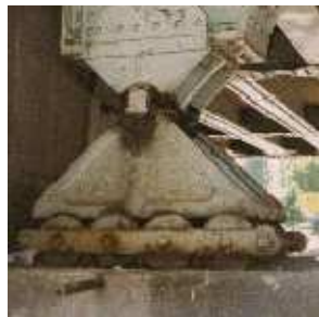
Figure VI.1 Appareil d'appui en acier
