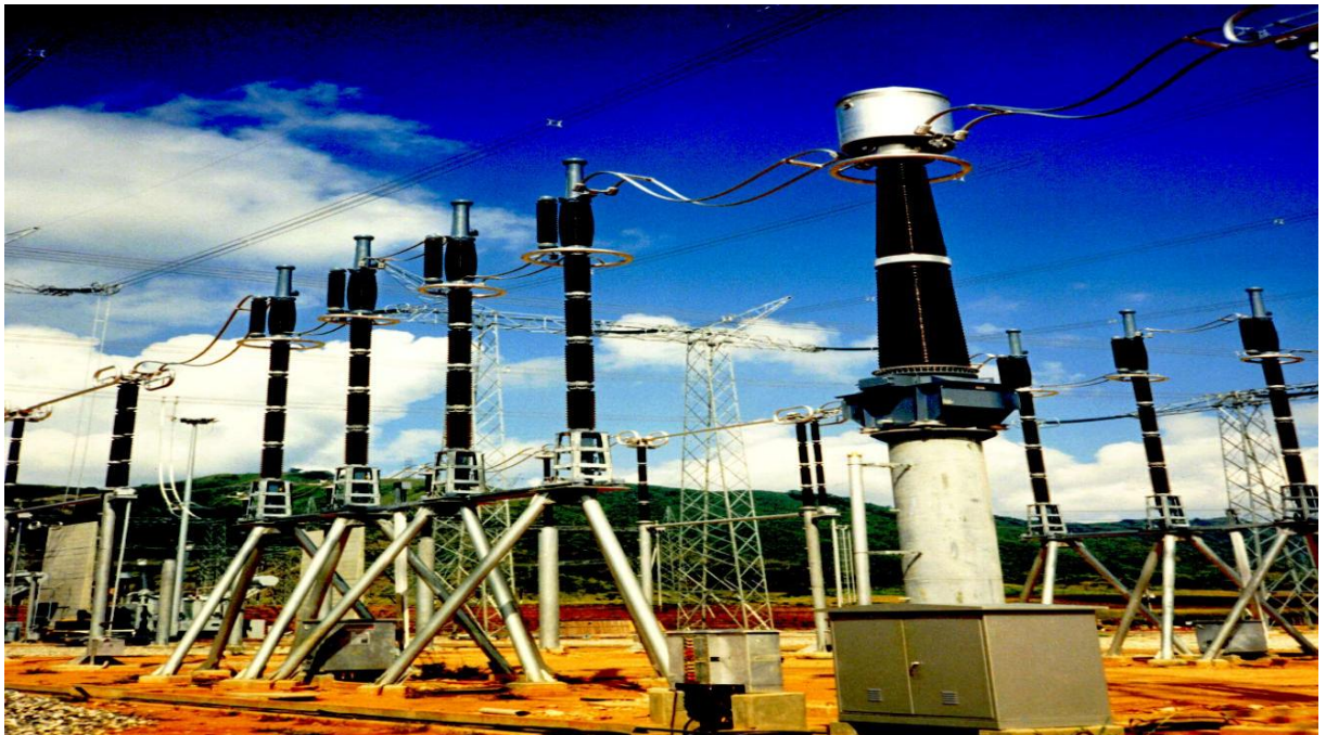
Figure I.10 : Disjoncteur 800 KV
