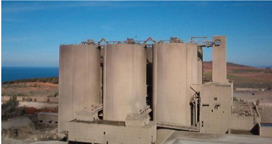
Fig.III.18. Silos de stockage de ciment (Cimenterie de Béni Saf)
