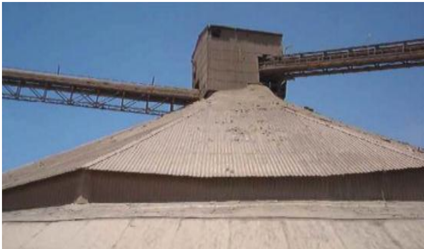
Fig.III.16. Les bulles de stockage du clinker (Cimenterie de Béni Saf)
