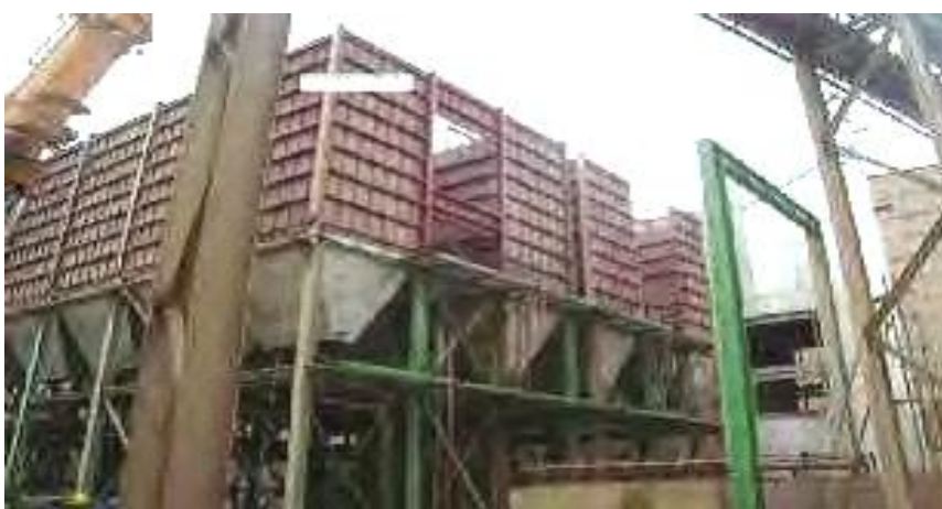
Fig. IV.19. Montage du nouveau filtre à manche [68]
