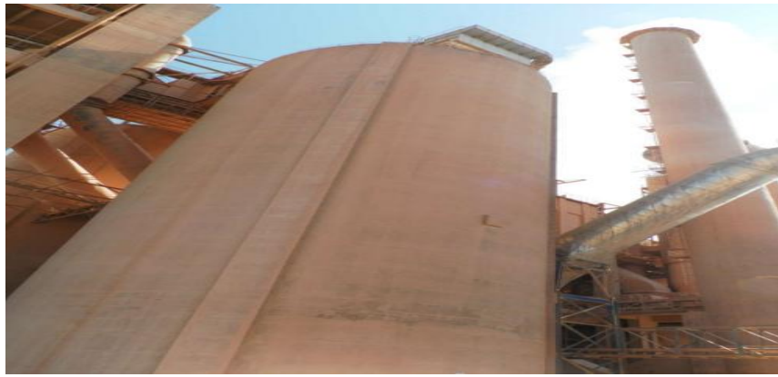
Fig. III.10. Silos d'homogénéisation (Cimenterie de Béni Saf)
