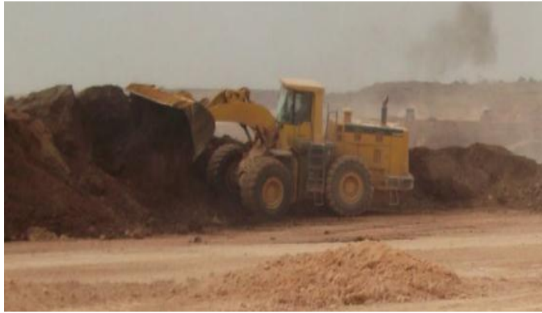
Fig. III.5. Extraction les engins dans la carrière de Béni-Saf
