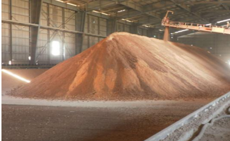
Fig. III.7. hall de pré-homogénéisation
