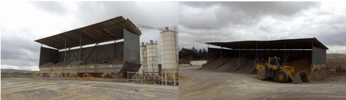
**Figure 2. 33 :** Le stockage des granulats sous un hangar (centrale à béton Italienne) (photos prises par les auteurs)
