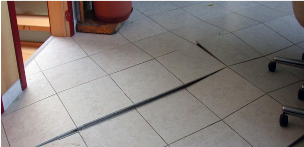
Figure 2.4: Faïence non homogène.
