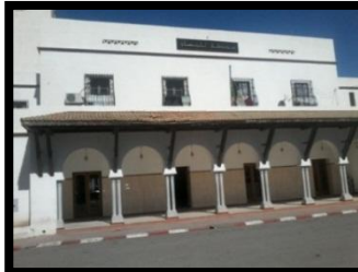
Figure 60: La gare ferroviaire
