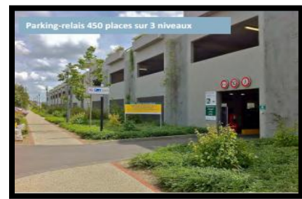
Figure 134 : Parking -relais 450 places sur 3 niveaux
