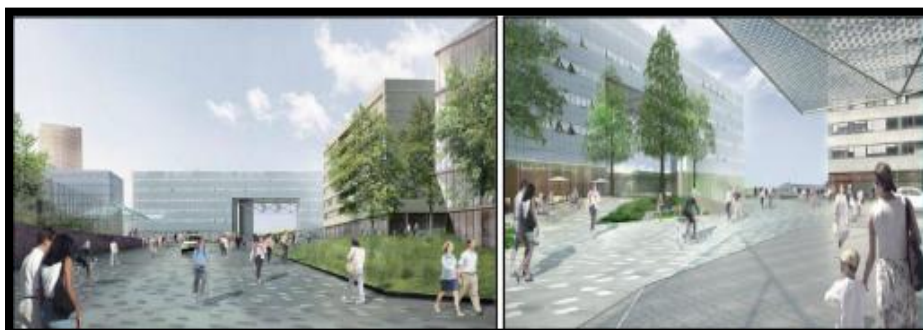
Figure 99: Nouvel accès sud au PME 67
