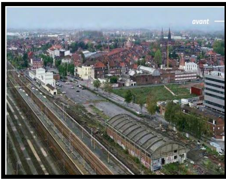
Figure 131 : Vue sur la gare avant 97
