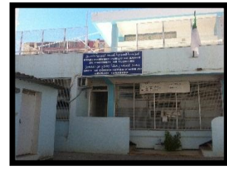
Figure 65 : Centre de sante
