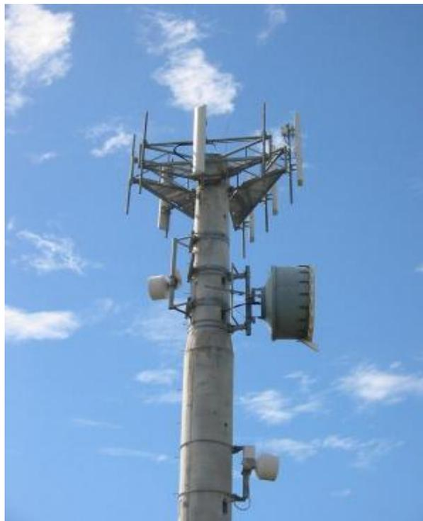
**Figure I.4: Exemple d'antennes GSM (BTS tri-sectorielles)[^2]**
