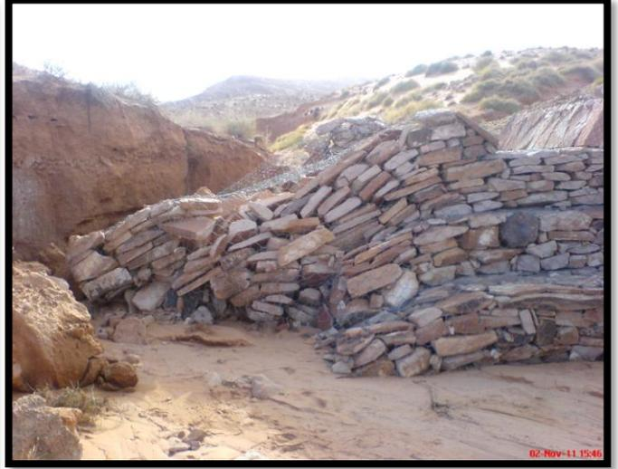
Photo n°25 et 26 : Seuil en gabion emportée par les eaux des pluies
