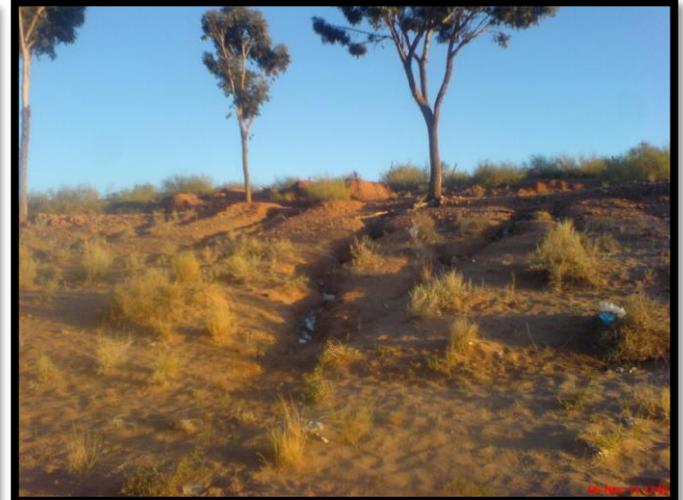
Photo n°27 : Destruction et envasement total d'un seuil
