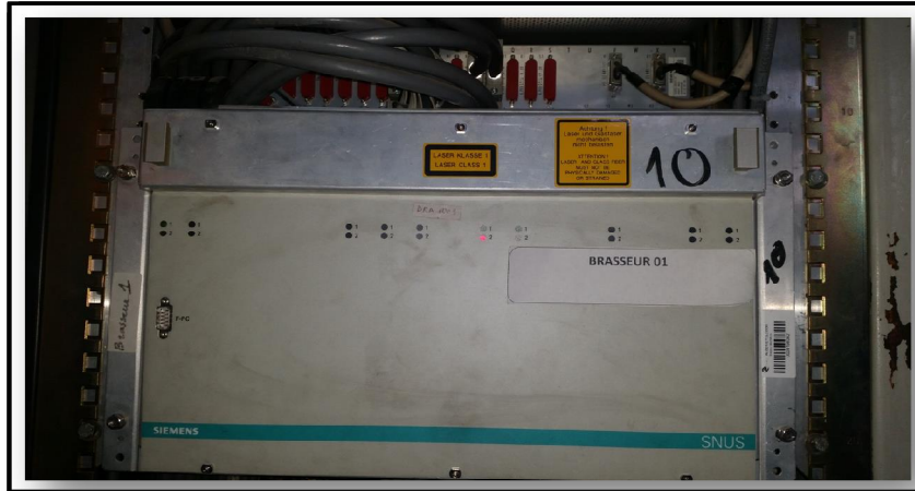
Figure II.9 : équipement d'un brasseur optique
