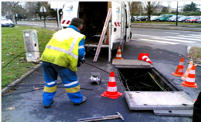
Figure III.8 : Méthode de tirage de fibre optique
