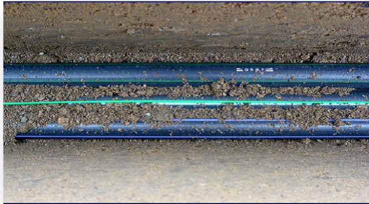
Figure III.2 : Fourreaux PEHD
