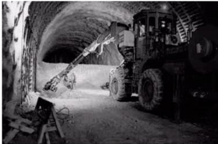
Figure. 1.6 : Creusement en demi-section. (Djenane M, 2010)
