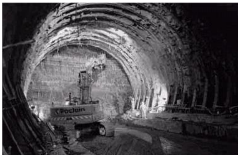
Figure. 1.7 : Creusement en pleine section. ( Djenane M, 2010 )
