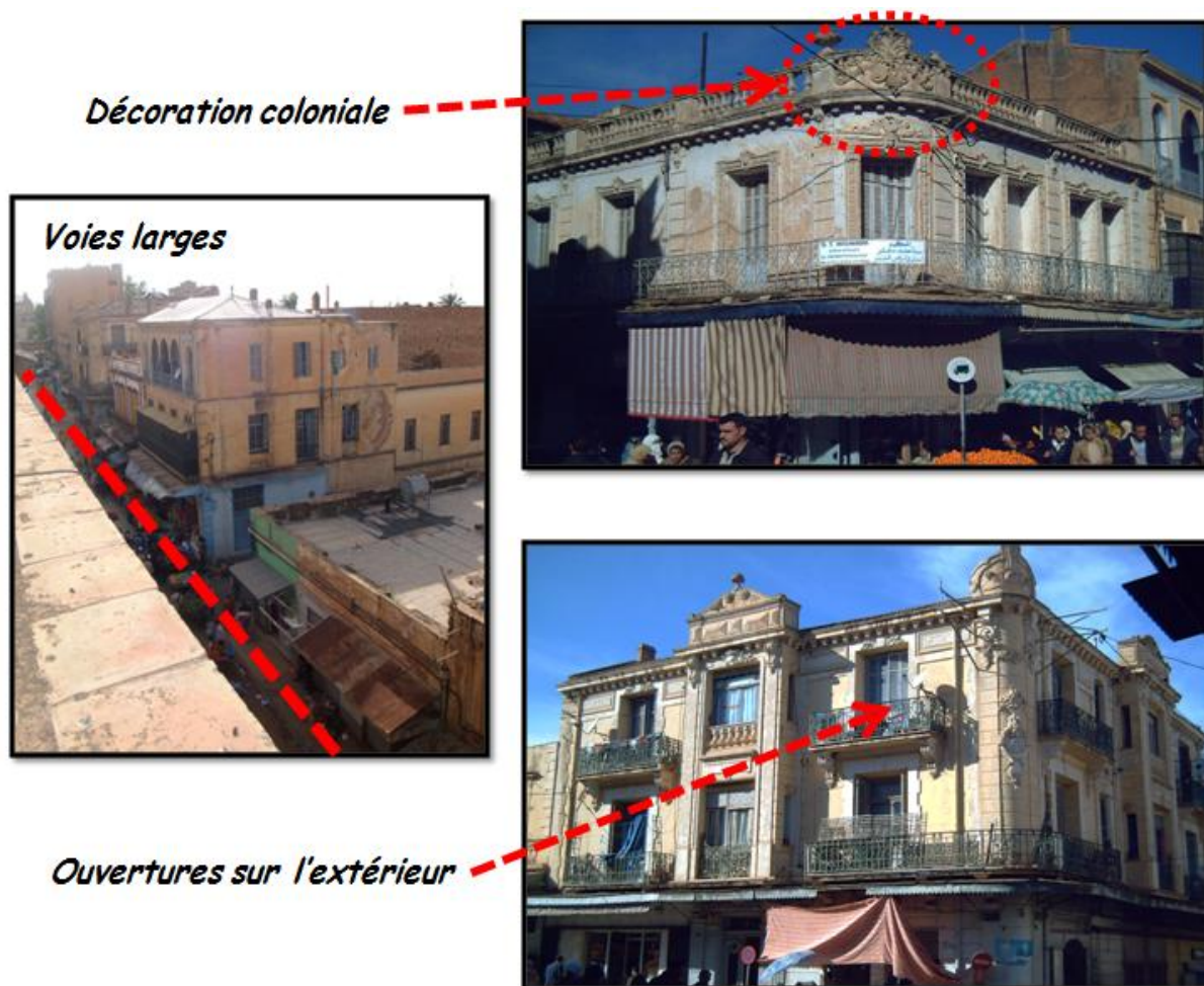
Fig.86: style colonial au niveau d'El Kissaria Source: auteur
