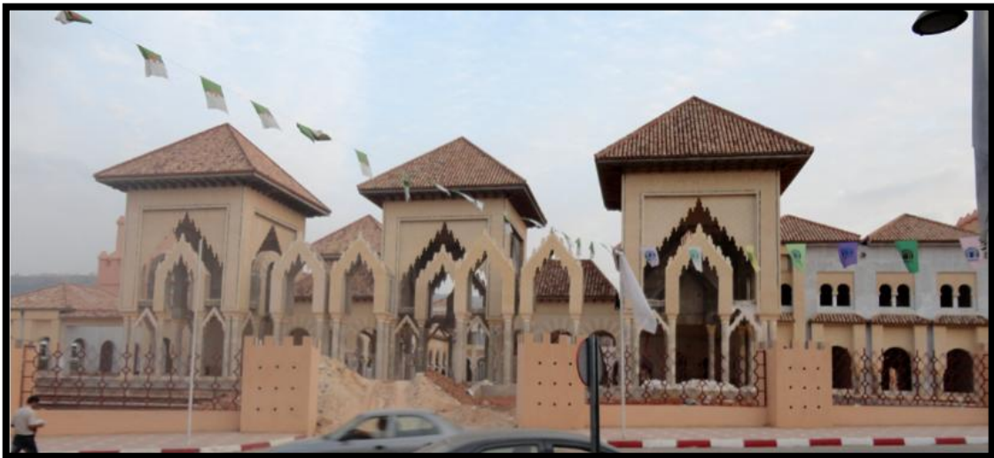
Fig.60 : le centre d'études andalouses -construction en cours- Source : Auteur -2011-
