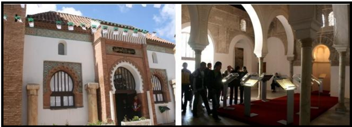
Fig.68: La mosquée de SIDI BELAHCEN après les travaux de restauration. Source : http://www.tlemcen2011.org
