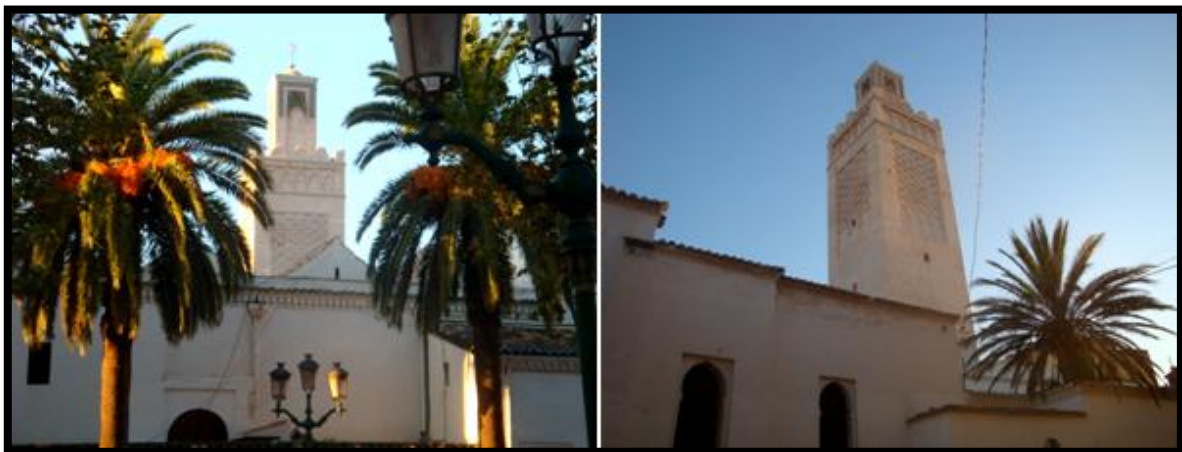
Fig.65 : La restauration de la grande mosquée de Tlemcen Source : auteur -2010-
