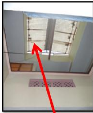
Couverture du patio
