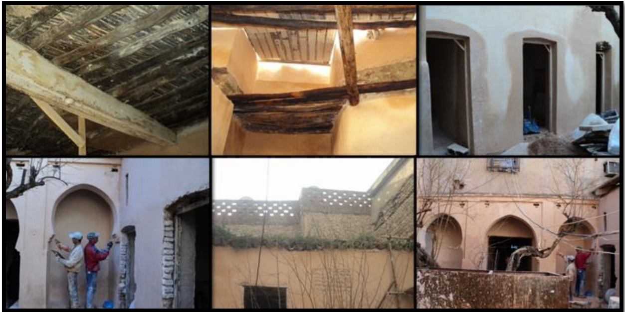
Fig.92: les travaux de restauration de fondouk Roumana Source: O.G.B.C.P
