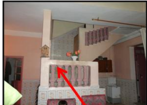
Traitement de la cage d'escalier
