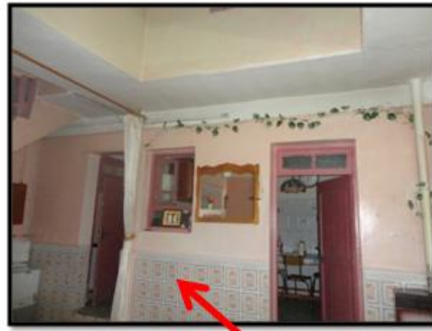
Revêtement des murs
