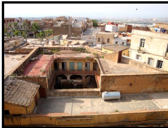
Fig.38 : Fondouk à Tlemcen Source : auteur
