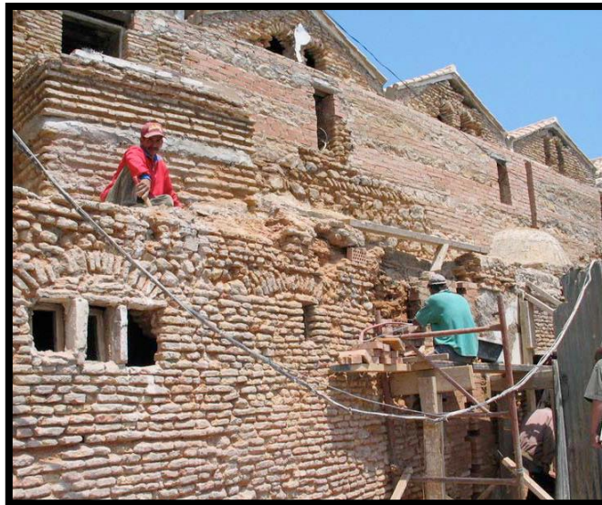
Fig.26: la restauration de la mosquée Sidi Abderrahmane Source : Larbi Icheboudene 144
