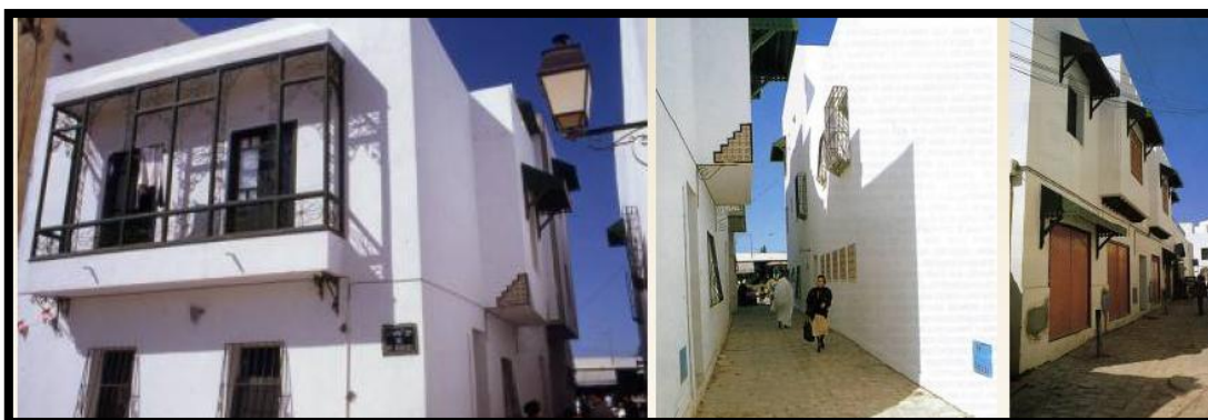
Fig.22 : le quartier HAFSSIA après sa réhabilitation Source : Association de sauvegarde de la médina de Tunis
