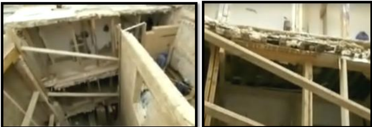
Fig.11 : restauration d'une maison à Fès Source : l'émission française: des racines et des ailes
