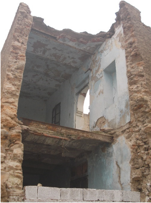
Photo 55: Habitation à deux niveaux avec l'utilisation des solives métalliques et des voutains en briques. (Source : Auteur, 2013)
