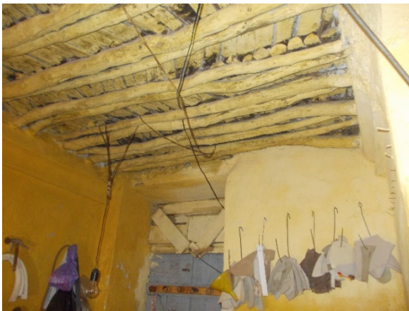
Photo 52: Plancher en bois dans un local de Babouchier. (Source : Auteur, 2013)
