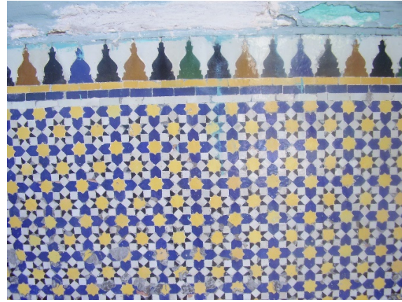
Photo 39: Détail du placage du Zellige au mur. (Source : Auteur, 2008)
