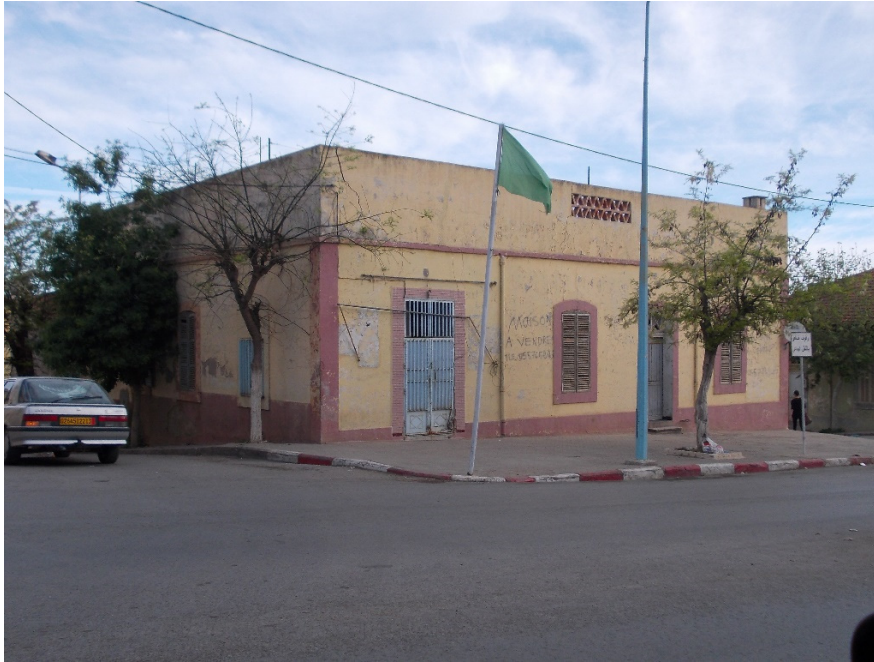
Photo 41: Habitation coloniale avec toiture plate accessible. (Source Auteur, 2017)
