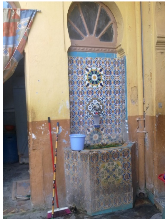
Photo 33: Fontaine aménagée dans l'ouverture d'une porte fermée. (Source : Auteur, 2014)
