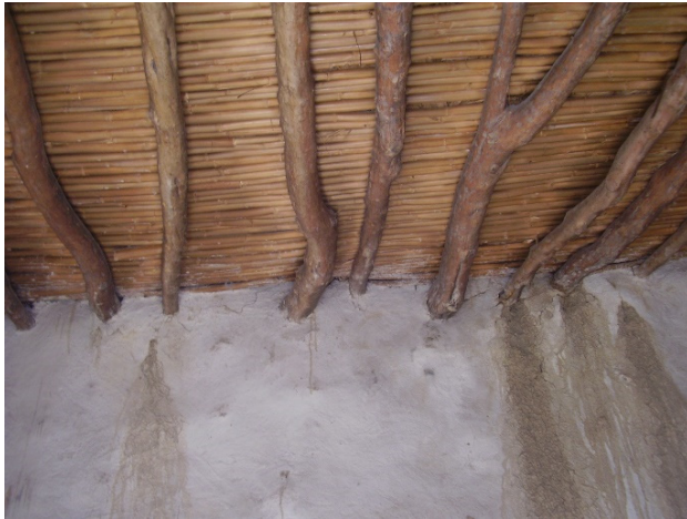
Photo 50: Plancher d'une habitation à Beni Meshe -Ain fettah. (Source : Auteur, 2012)
