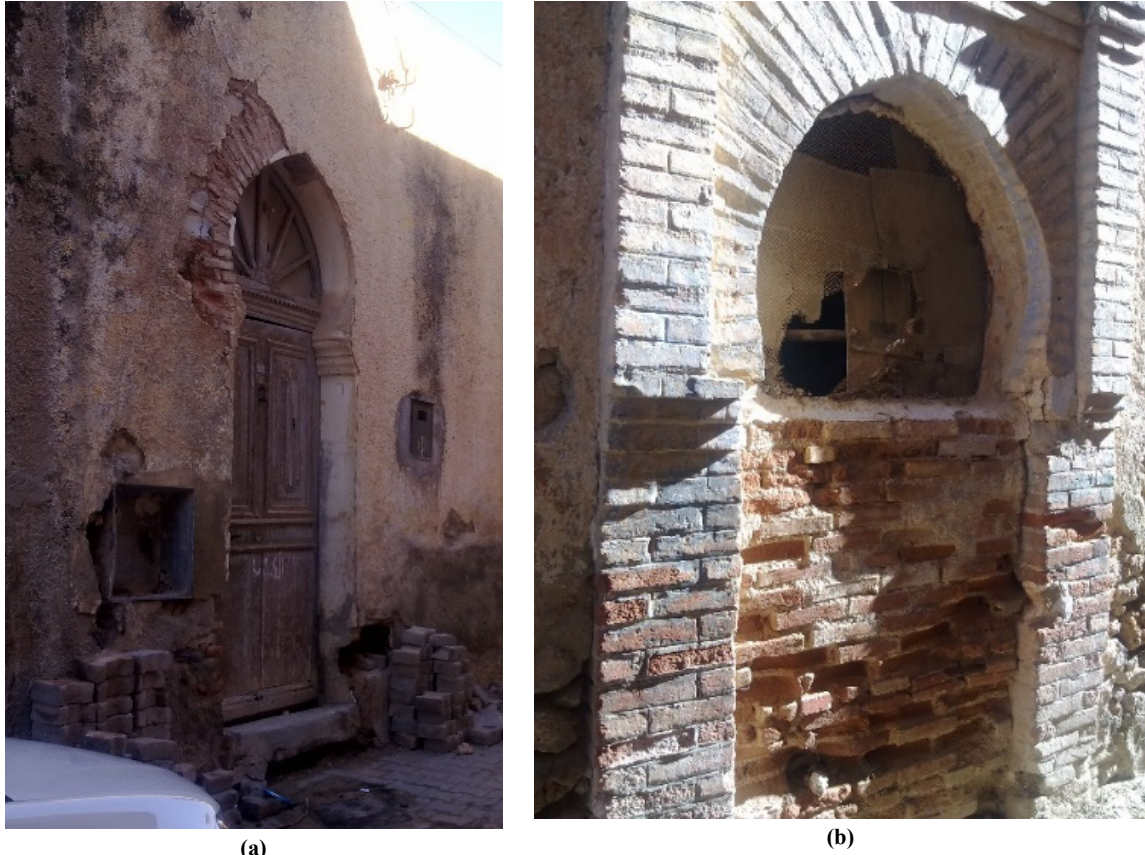
(a) (b) Photo 54: (a), (b), ouvertures de portes d'entrée réalisées en brique pleine. (Source : Auteur, 2014)
