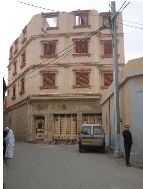
Photo 69: L'habitation une fois terminée. (Source : Auteur, 2013)
