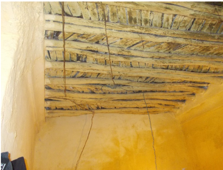
Photo 24: Détail d'un plancher dans local artisanal. (Source Auteur, 2014)
