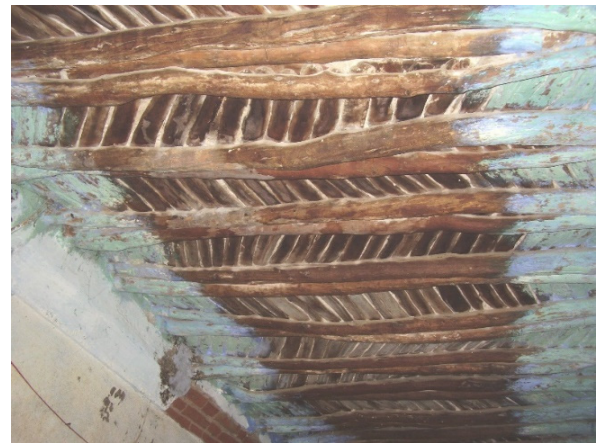
Photo 53: Plancher en bois dans un byt. (Source : Auteur, 2008)
