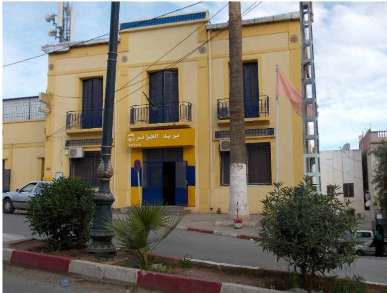
Photo 9: La grande poste de Nédroma. (Source : Auteur, 2016)
