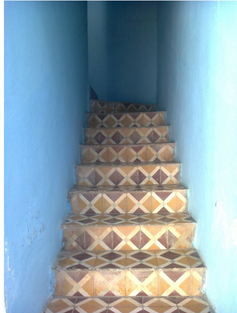
Photo 37: Escalier entre deux murs à Dar Baghdadi. (Source : Auteurs, 2014)
