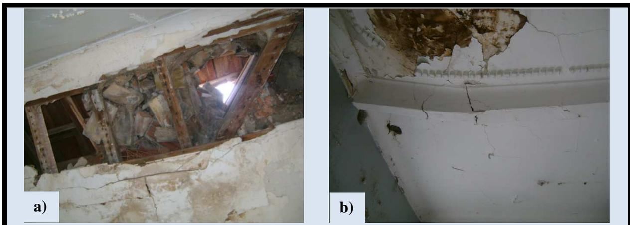
**Figure [86] :** Photos des endommagements ; a) La cheminée, b) La poutre en bois, source : l'auteur La rupture des cheminés et des poutres en bois, source : l'auteur.
