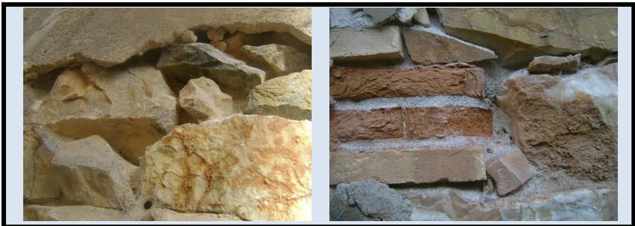
**Figure [93] :** Photos de l'éclatement des enduits sur les façades extérieures, source : l'auteur.
