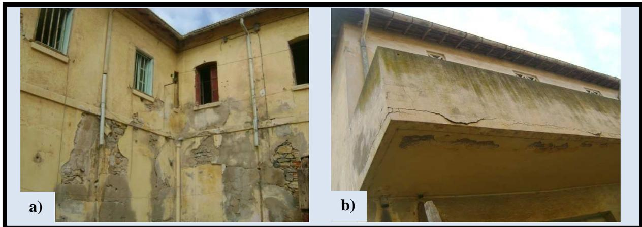
**Figure [85] :** Photos de fissures et ruptures d'enduits ; a) Les murs de façade des anciens blocs, b) Le balcon de l'extension, source : l'auteur.
