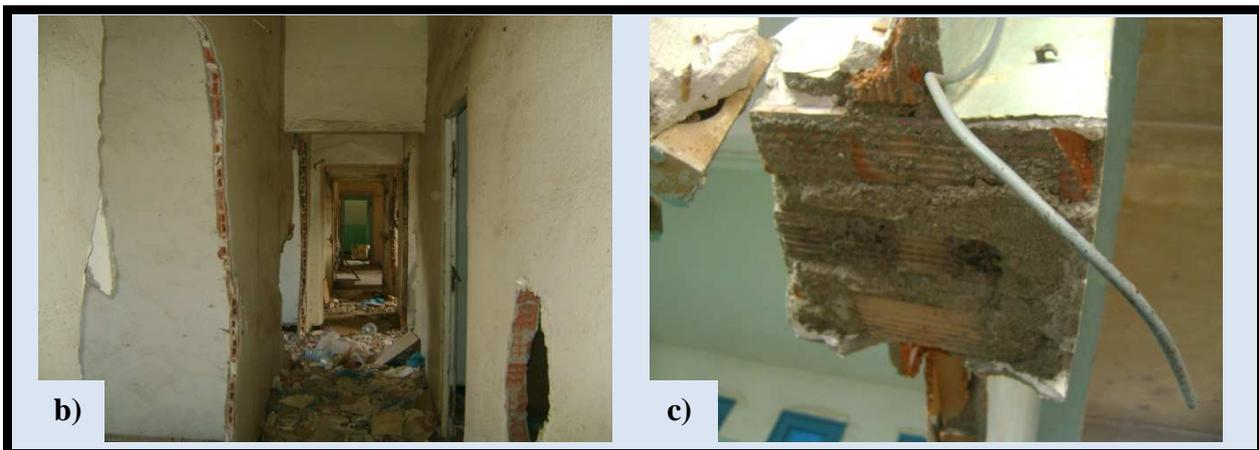
**Figure [87]** : Photos des endommagements ; a) L'escalier en bois, b) Les cloisons, c) Le poteau, source : l'auteur.
