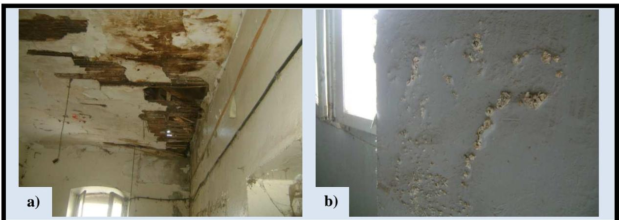
Figure [91] : Photos des traces d'humidité ; a) Le plafond, b) Le mur, source : l'auteur.
