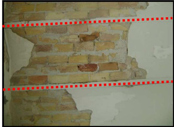
**Figure [80]** : Photo des planchers en voutains, source : l'auteur.
