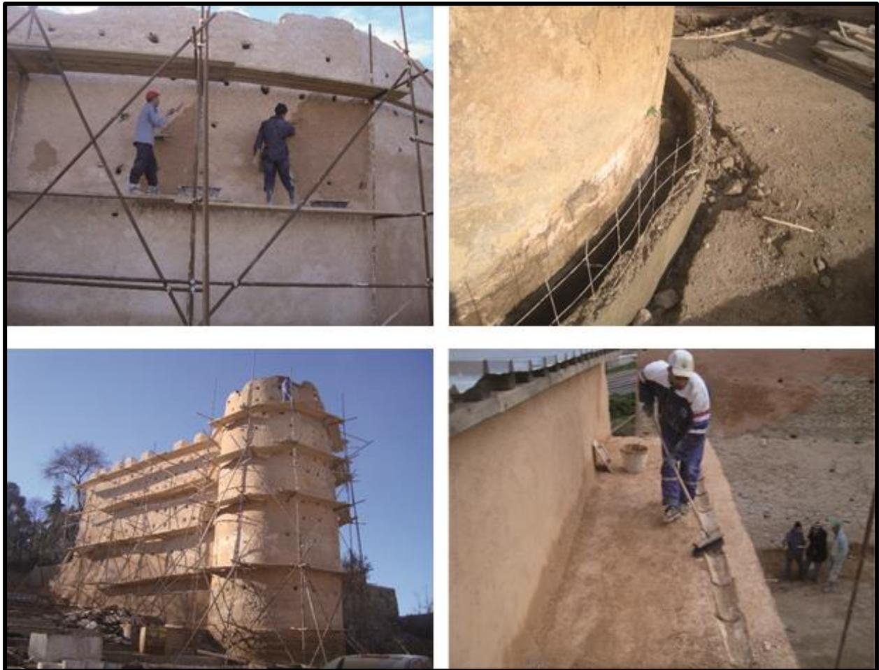
**Figure 132.** Mise hors d'eau et reprise d'enduits. Chantier de restauration 2010.
