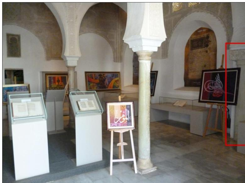
Photo 26 : La colonne demi-incrustée remplaçant celle endommagée
