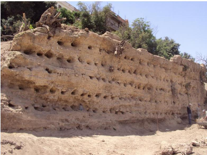
Ce mur sert de soutènement aux terres agricoles se trouvant au dessus, il appartient à une série de fragment entrecoupée constituant la muraille défensive nord.
