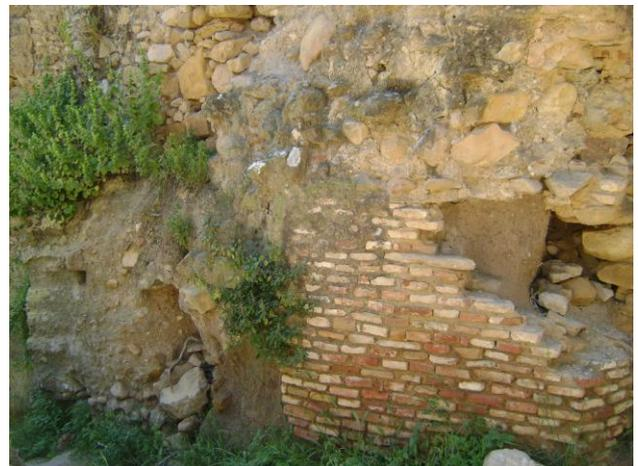
Photo n°104: Détérioration du pisé d'une des tours. Source: l'auteur
