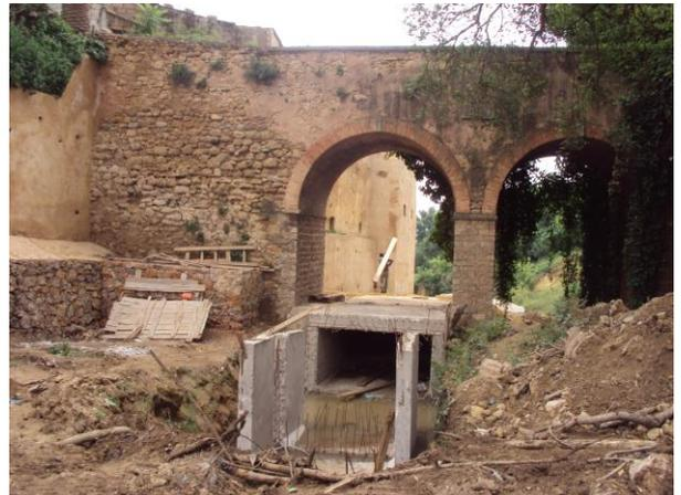
Photo n°112: Travaux de VRD avec passage de daleaux à travers une des arcades du pont. Travaux de 2010. Source: l'auteur
