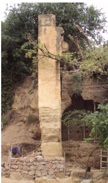
Photo n°45: La consolidation par la reprise en sous œuvre des parties manquantes de la base du mur constituant la tour de la porte en chicane, avec élargissement de la base de la reprise pour une meilleur consolidation et surtout protection contre les agressions hydriques (débordement de oued Metchkana) et mécaniques (circulation d'engins de travaux publics sur le site). Travaux de restauration du site en 2010. Source l'auteur.
