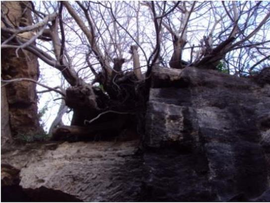
Photo n°30: La nature reprend ses droits. Invasion de la végétation nuisible. Toiture de la porte en chicane
