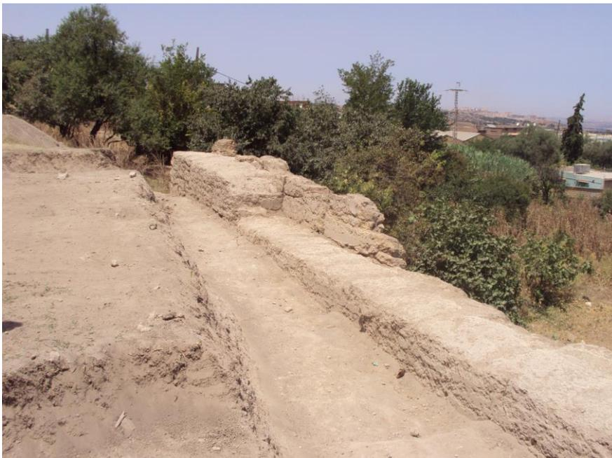
Photo n°53: Abaissement du niveau des terres afin d'amoindrir les poussées sur les fragments de la muraille nord. Travaux de restauration de la muraille nord 2010. Source l'auteur.
