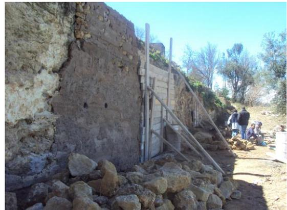
Photo n°96: Mise en valeur d'un des fragments de la muraille nord par une reprise en sous œuvre des parties endommagées 2010. Source: l'auteur
