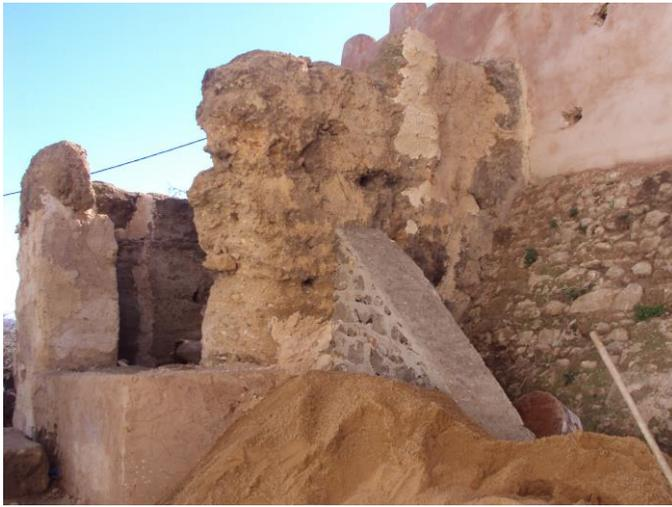
Photo n°43: La consolidation par un étayage permanent d'un fragment de la muraille nord lors des travaux d'aménagement du site en 2010. Source l'auteur.
