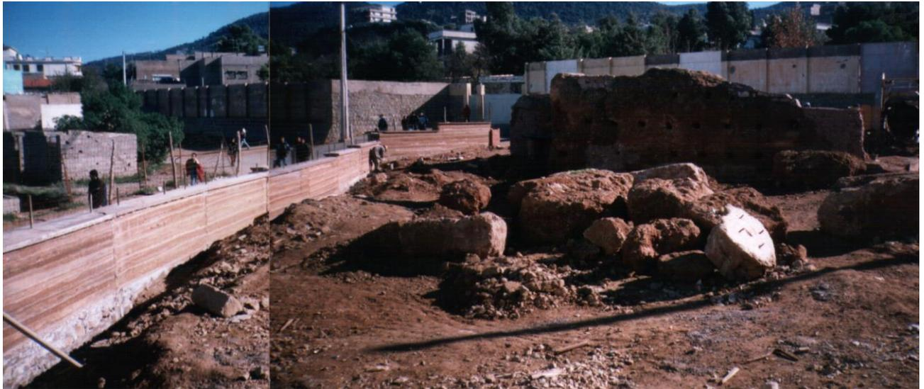
Photo n°58: Protection d'un site historique par un muret en pisé. Travaux concernant les fragments de muraille méridionale sise au terrain Belkhodja en 1998. Source l'auteur.
