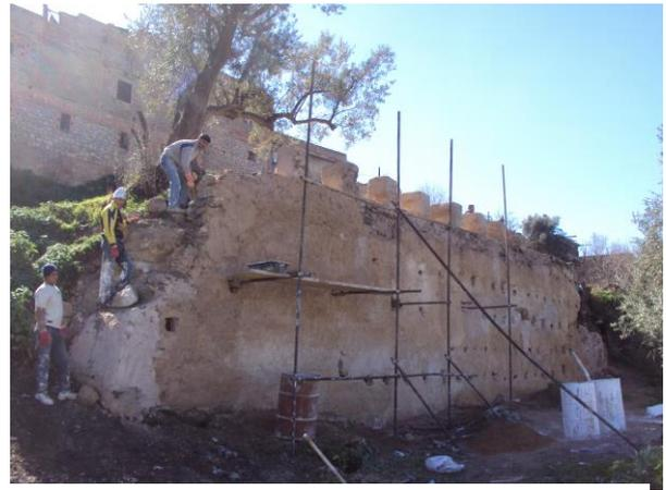
Photo n°94: Réparation des parois des murs en pisé par des enduits à la chaux de la muraille nord en 2010 Source: l'auteur
