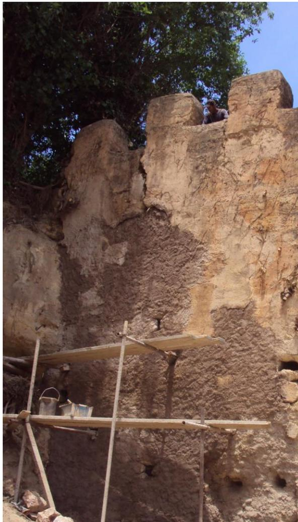
Photo n°47: La consolidation du mur en pisé de la porte en chicane par la reprise des fissures.
