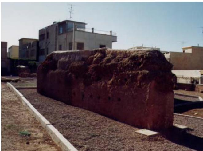
Photo n°56: Disposition du gravier autour des murs contre le rejaillissement. Terrain Belkhodja 1997. Source l'auteur.
