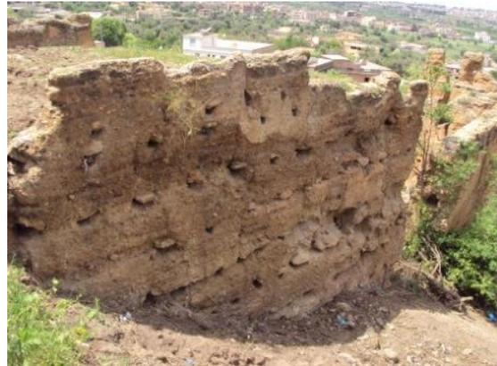
Photo n°31: L'érosion. Dans ce cas on constate l'érosion du pisé par les eaux de pluie et les vents. Pan de mur à hammam bent essoltane
