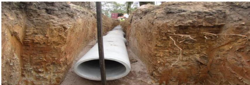
Photo n°55: pose des tuyauteries pour drainage du sol. Travaux de restauration de hammam el Ghoula en 1999. Source l'auteur.
