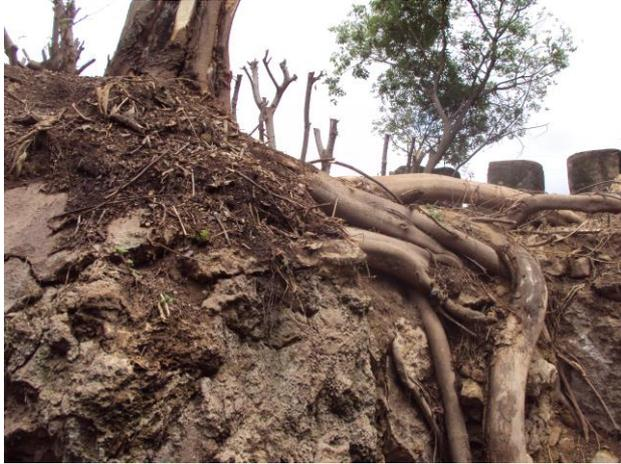
Photo n°39: Pénétration des racines dans les murs. Porte en chicane lors de sa restauration en 2010. Source l'auteur.
