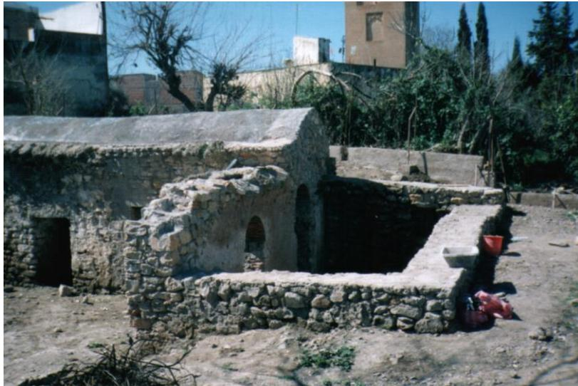
Photo n°46: La consolidation de la maçonnerie en moellons par l'injection du coulis de chaux lors des travaux de restauration du site de hammam el Ghoula en 1999. Source l'auteur.
