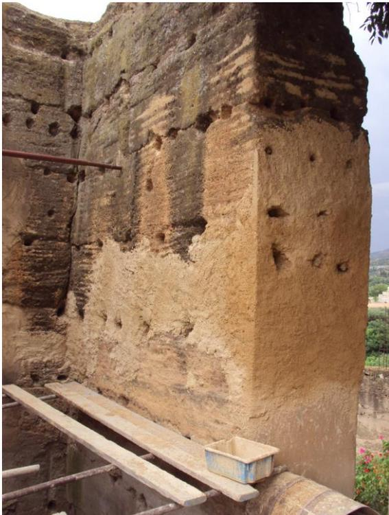
Photo n°51: La consolidation d'une tour appartenant à bordj essoltane par l'utilisation d'un tirant métallique lors des travaux de restauration de la muraille sud 1999. Source l'auteur.
