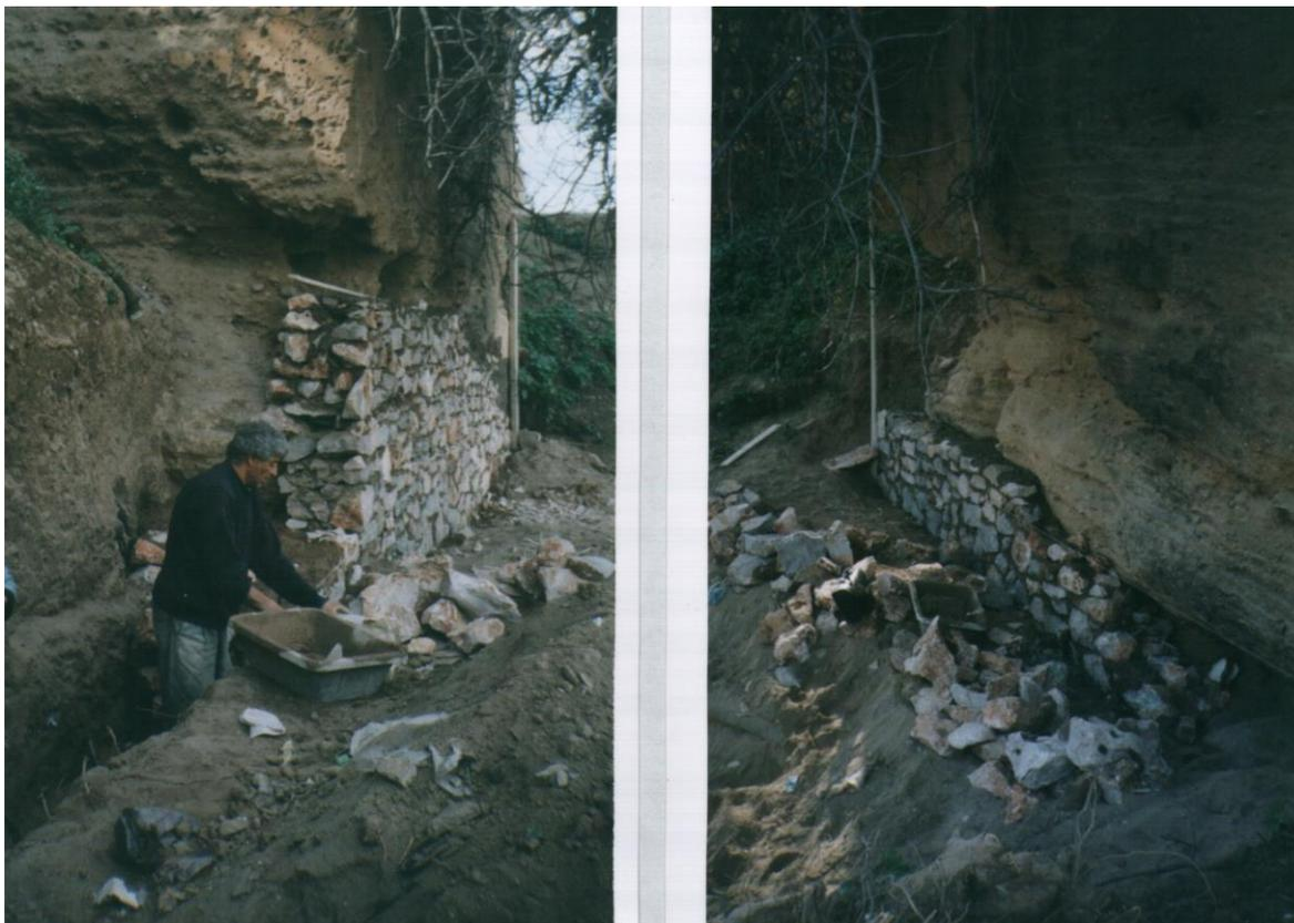
Photo n°44: La consolidation par la reprise en sous œuvre des parties manquantes de la base du mur constituant la tour de bordj essoltane en utilisant la pierre reliée avec du mortier de chaux. Travaux de restauration du site en 1999. Source l'auteur.
