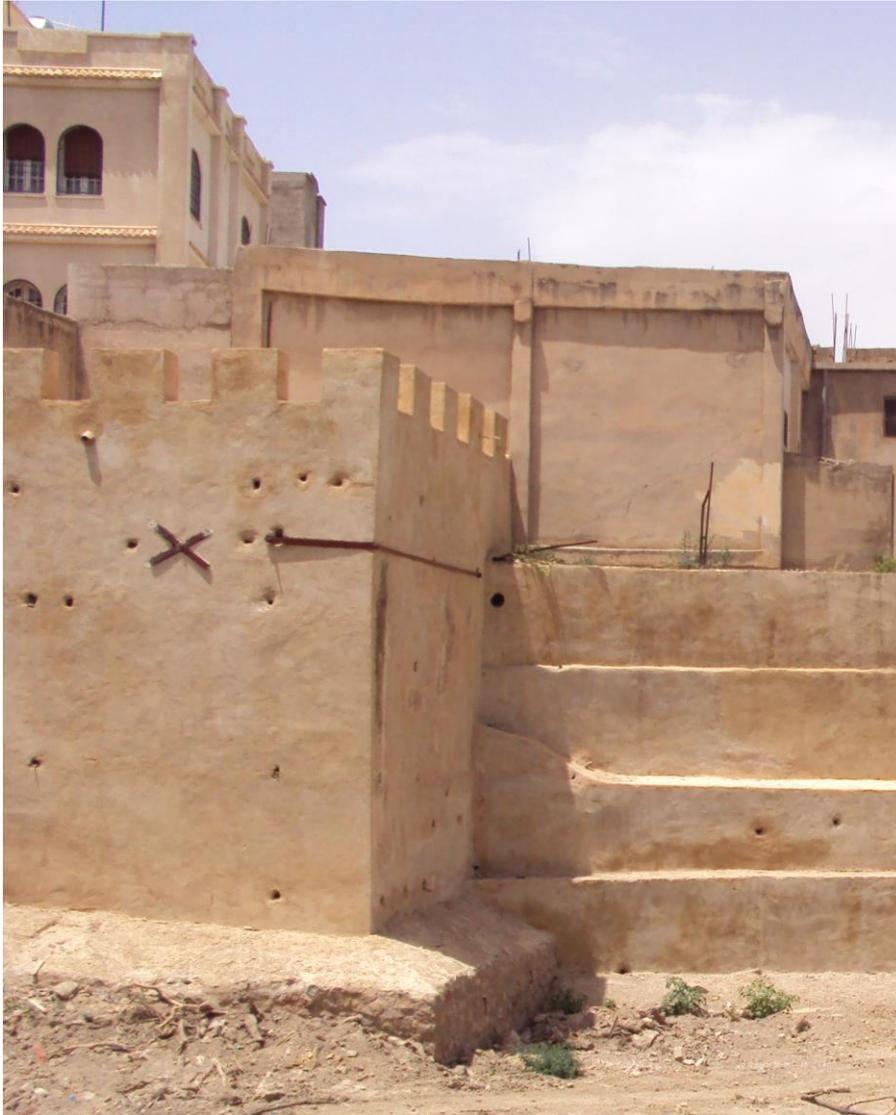
Photo n°50: La consolidation d'une tour appartenant à la muraille sud par l'utilisation des chainages métalliques périphériques, ainsi qu'un tirant métallique visible par sa croix lors des travaux de restauration de la muraille sud 2010. Source l'auteur.
