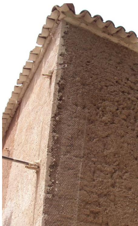
Le dosage du mortier est le suivant: Ils ont un rôle important dans l'aspect de l'édifice. Ces enduits sont constitués par un mortier de chaux grasse et du sable, posés en plusieurs couches et espacés d'au moins une semaine.
