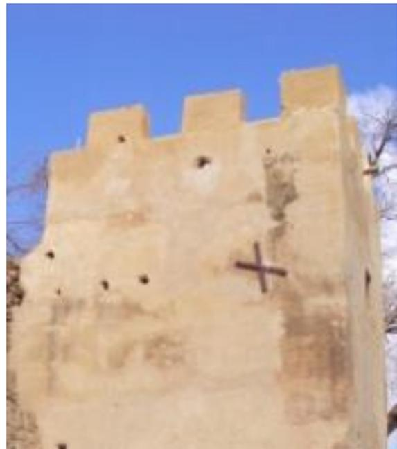
Photo n°52: La consolidation d'une tour appartenant à la muraille sud par l'utilisation d'un tirant métallique visible par sa croix lors des travaux de restauration de la muraille sud 2010. Source l'auteur.
