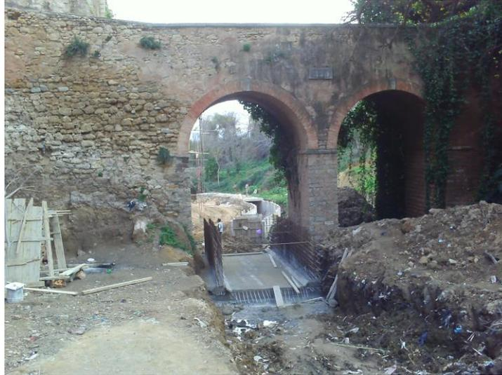
Photo n°74: Pont en pierre. Travaux en cours de pose de daleaux au dessous du pont en pierre en 2010. Source: l'auteur.
