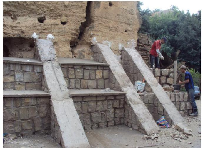
Photo n°42: La consolidation par un étayage permanent du mur sur du hammam bent essoltane lors des travaux d'aménagement du site en 2010. Source l'auteur.
