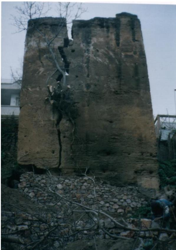
Photo n°35: Effet de la croissance de l'arbre sur l'intégrité de la tour. Travaux de restauration du site de bordj essoltane en 1999. Source l'auteur.
