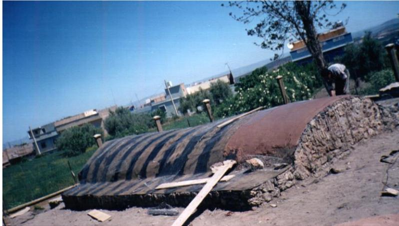
Photo n°54: Protection de la voûte de hammam el Ghoula par du feutre bitumé et protégé par une chape en mortier de chaux consolidé par un grillage fin inoxydable. Travaux de restauration de hammam el Ghoula en 1999. Source l'auteur.
