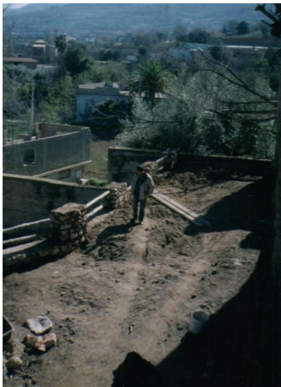
Photo n°59: Réalisation de terrasses et d'esplanades avec murets en pierre et balustrades en rondins de bois. Travaux de restauration de bordj essoltane en 1999. Source l'auteur.
