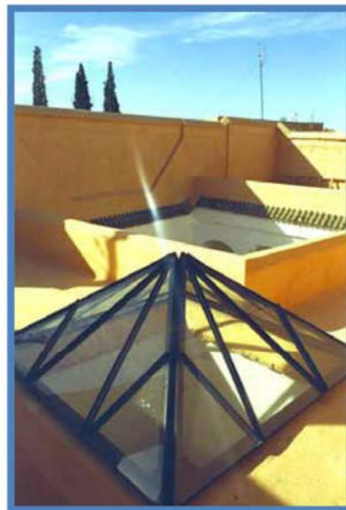
**Fig. N°05:** la finition d'escalier et la couverture du patio.
