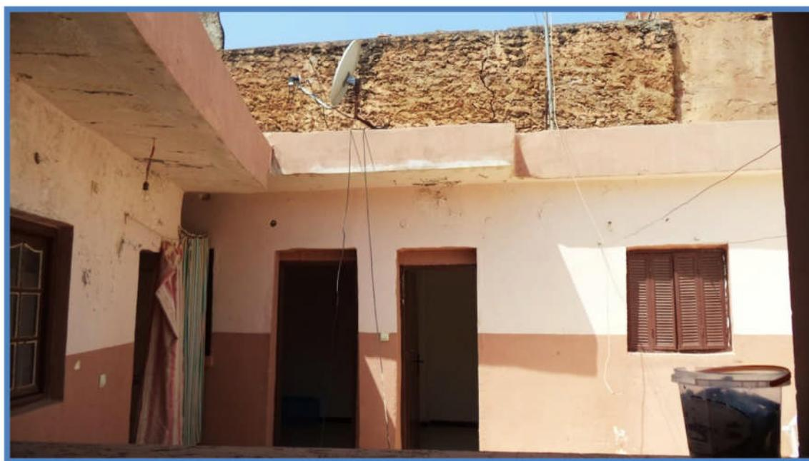
**Fig. N°60** :appropriation par l' Ajout des pièces a l'étage par utilisation des matériaux nouveaux.
