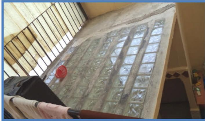
**Fig. N°49** : la couverture de la moitié du patio par une dalle de brique de verre.
