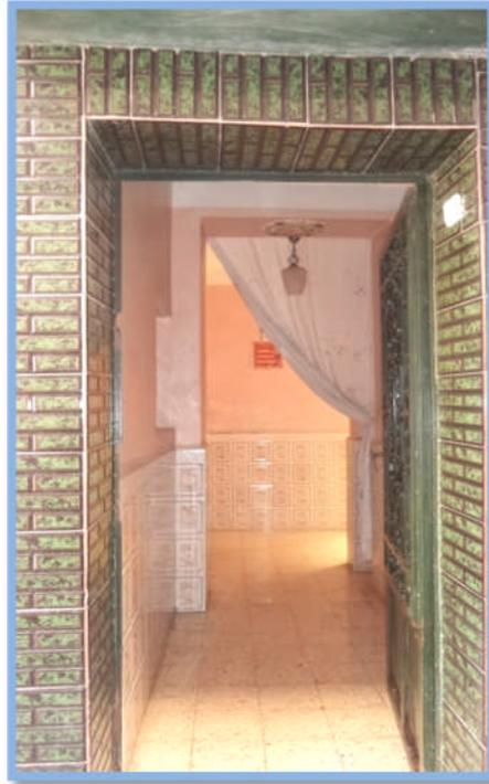
**Fig. N°23** :le traitement de l'entrée principale par un nouveau matériau et le changement de la porte d'entrée en fer forgé.
