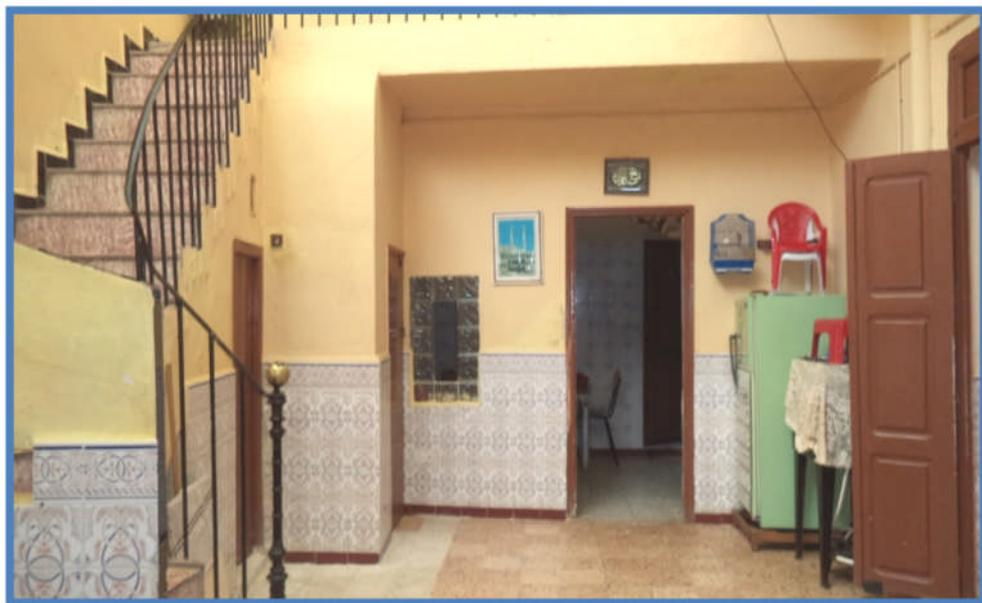
**Fig. N°47 :** l' Ajout et l' aménagement des pièces par des nouveaux matériaux (faïence, carrelage, brique de verre).
