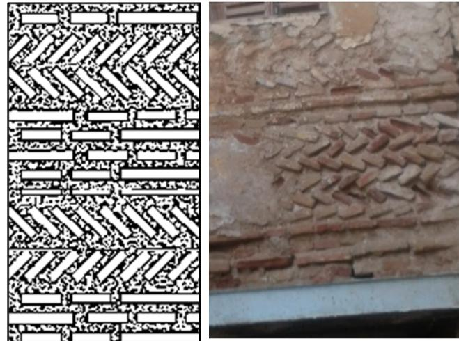
**Fig. 97 :** Mur à double strates irrégulières horizontale et en arrête de brique de terre cuite.
