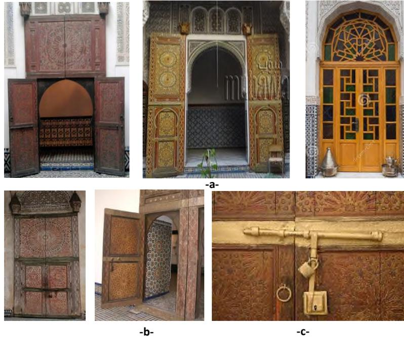
**Fig. 46:** Portes intérieures de maisons traditionnelles à Fès –a- Modèles de portes –b- Détail de vantail –c- Système de fermeture d’une porte intérieure.
