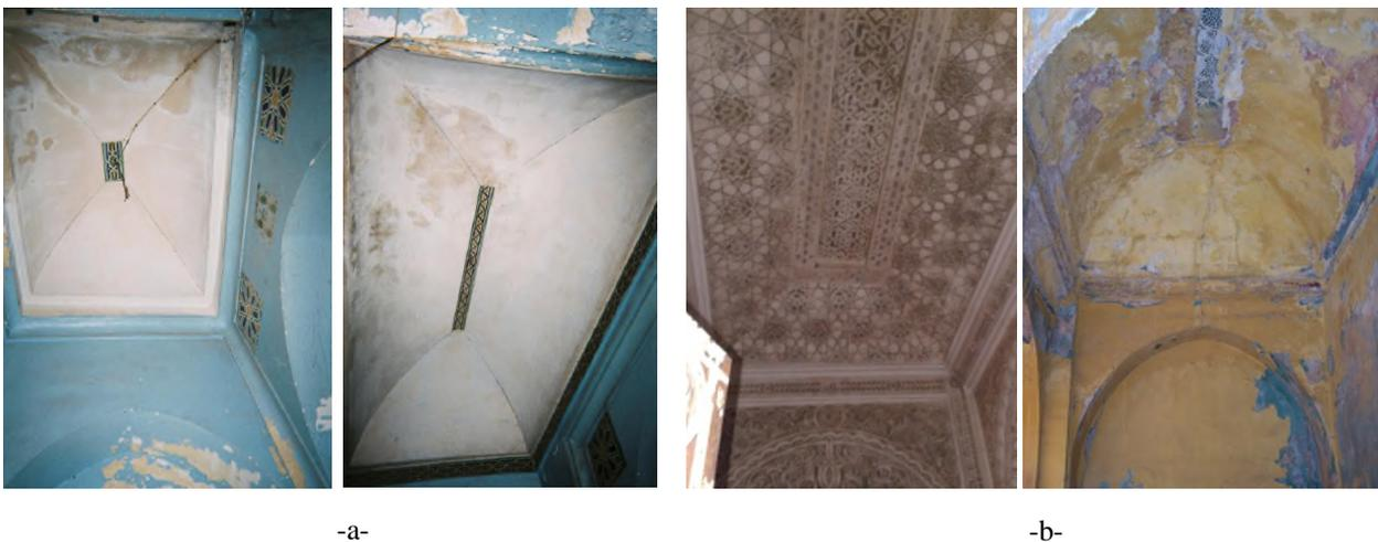
**Fig. 118** : typologie des voûtes dans des maisons de la médina de Tlemcen –a- voûtes d'arrête – b- voûtes en arc de cloître. Source : auteur.
