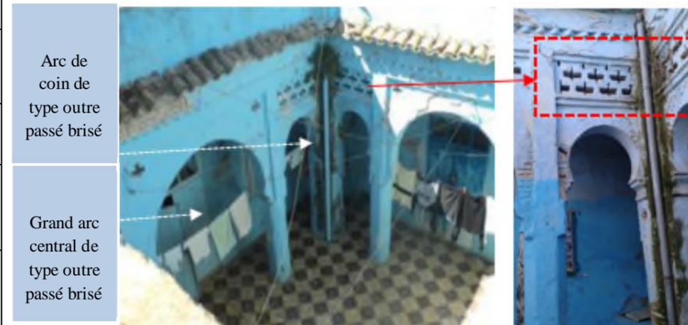
Fig. 82 : Modèle des galeries de Dar Baroudi de Derb Sensla. Source : auteur
