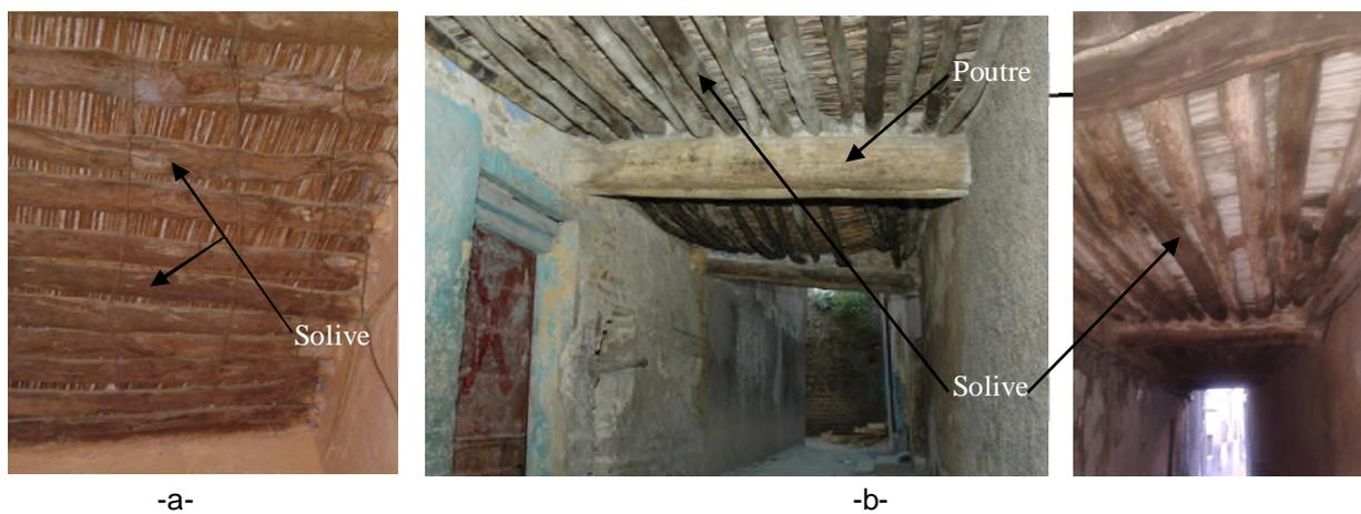
**Fig. 116 :** Plancher –a- à travure simple –b- à travure composée.
