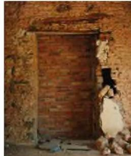
**Fig. 25:** Mur en briques renforcé par des rondins de bois.
