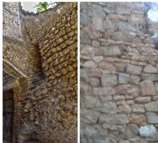
**Fig. 100 :** Mur porteur en maçonnerie de pierre avec calage réalisé au moyen des chutes de la taille des blocs de pierre et de brique de terre cuite.
