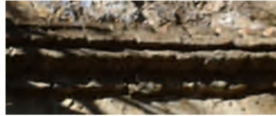
Corniche d'une maison traditionnelle de Bâb JIAD composée de plusieurs rangées de briques en terre cuite noyées dans le mortier.
