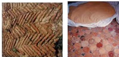
**Fig. 24:** Carreaux de terre cuite pour le sol.
