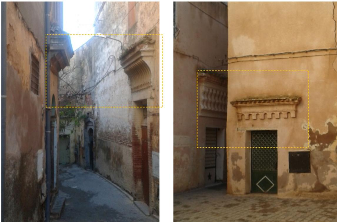
**Fig. 125 :** Encorbellements surmontant des entrées des maisons à Koran Kbir. Et à Derb Sidi Zekri
