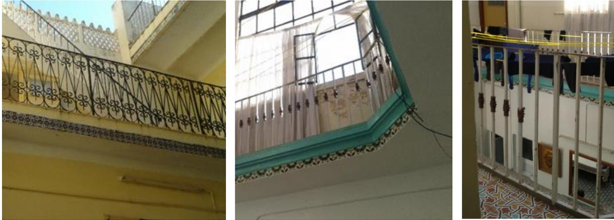
**Fig. 132 :** Balustrades métalliques en fer forgé.
