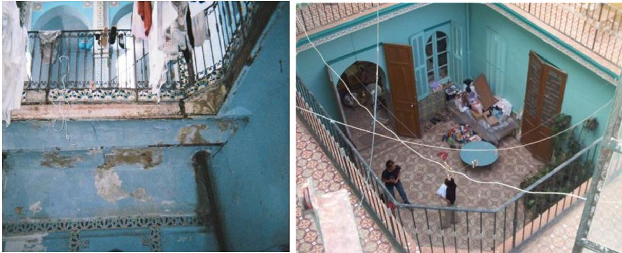
**Fig. 129 :** Suppression des arcades qui entourent le patio après transformation des planchers.
