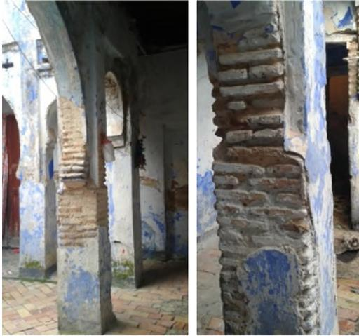
**Fig. 106 :** Type d'appareillage d'un pilier en brique de terre cuite.
