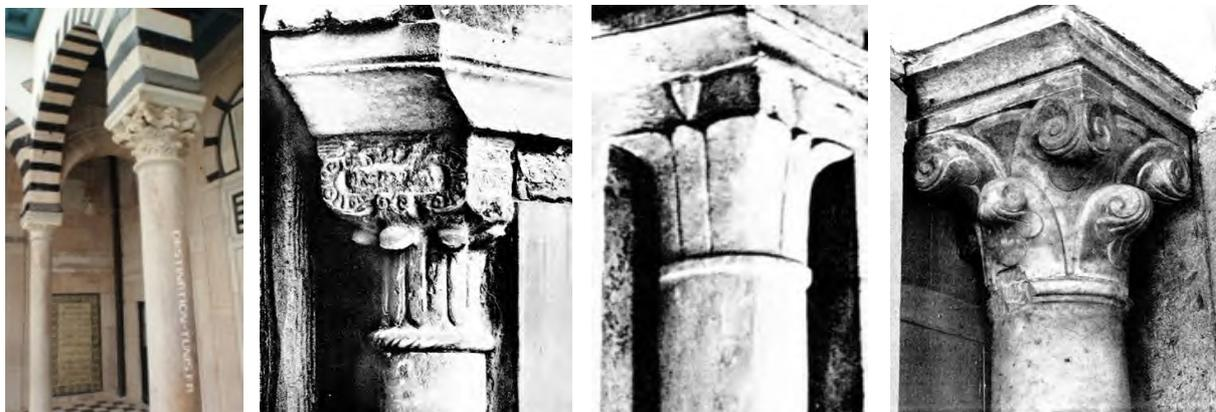
**Fig. 60:** Colonnes et chapiteaux –a- Détail d'arcade –b- chapiteau de type hispano-mauresque –c- chapiteau de type hafside –d- chapiteau turc.
