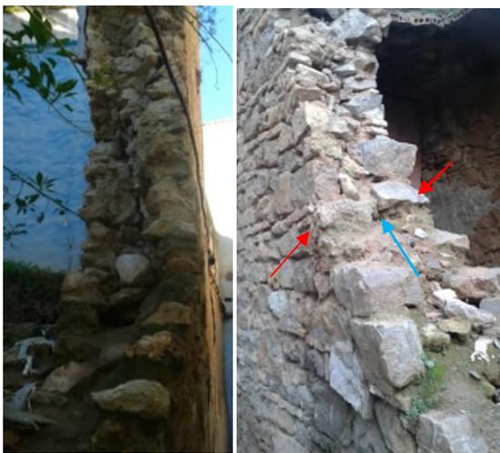
**Fig. 99 :** Coupe verticale illustrant un mur porteur en maçonnerie de pierre (moellon).
