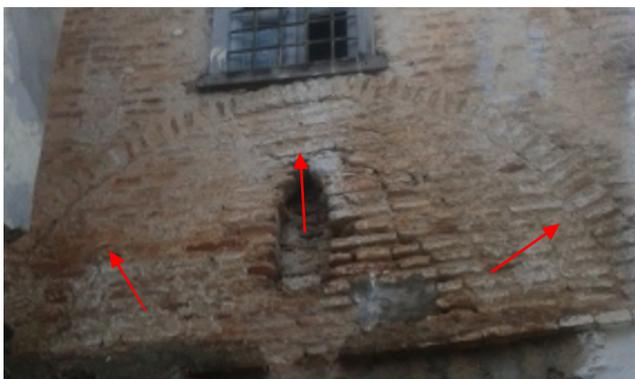
**Fig. 98 :** Mur en brique de terre cuite renforcé par un arc de décharge.
