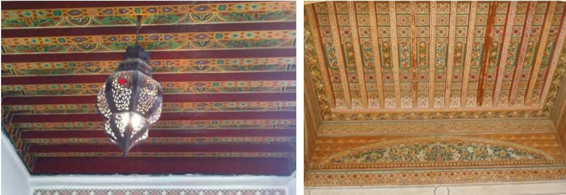
**Fig. 48 :** Charpente en bois Bissat.
