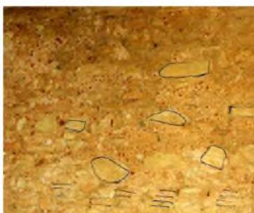
**Fig. 27:** Murs renforcés par une strate de brique curviligne
