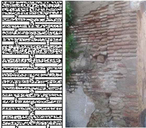
**Fig. 96 :** Mur à strates horizontale de brique de terre cuite.
