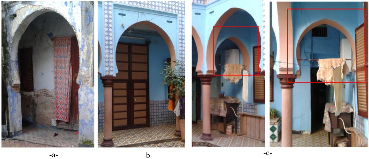
**Fig. 109 :** Types des arcs –a- arc outrepassé –b- arc outrepassé brisé –c- arc de contreventement.
