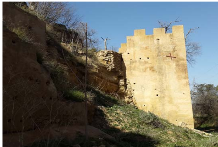
4- vue extérieure d'une tour barlongue
