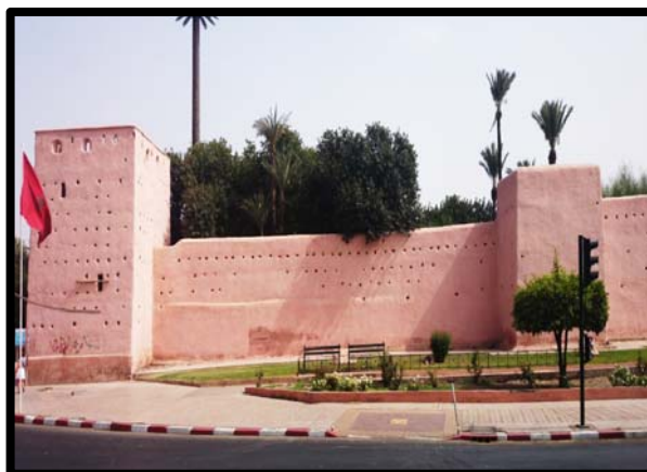
Figure 91 : Rempart de Marrakech
