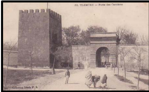
Figure 202 : Porte des Carrières
