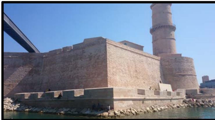
Figure 51 : bastion du vieux port a Marseille
