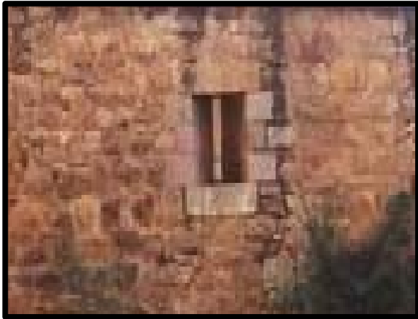
Figure 209: Vue sur une meurtrière
