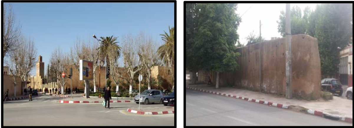
Figure 146 : Rempart sud du Méchouar et fragment du Bit El Rich
