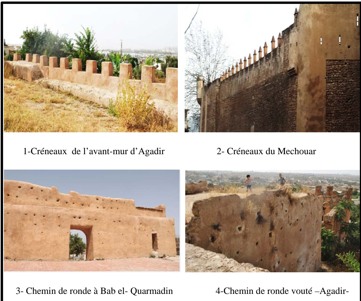
Figure 167 : Couronnement du rempart de Tlemcen
