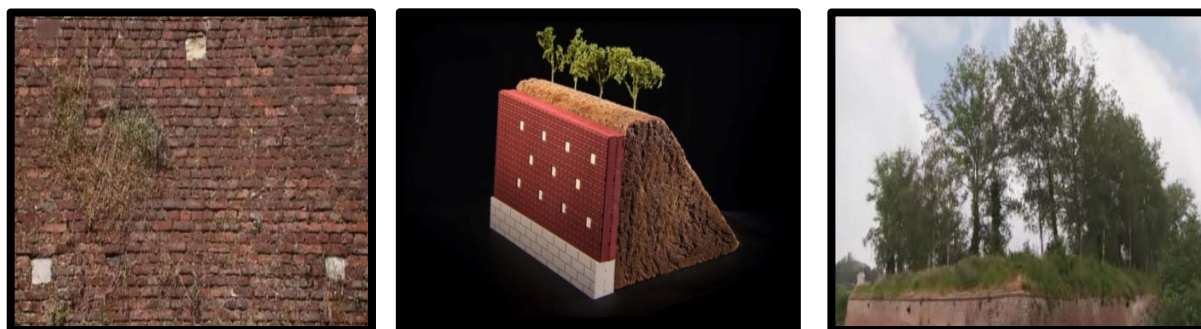
Figure49 : Composition de la muraille.
