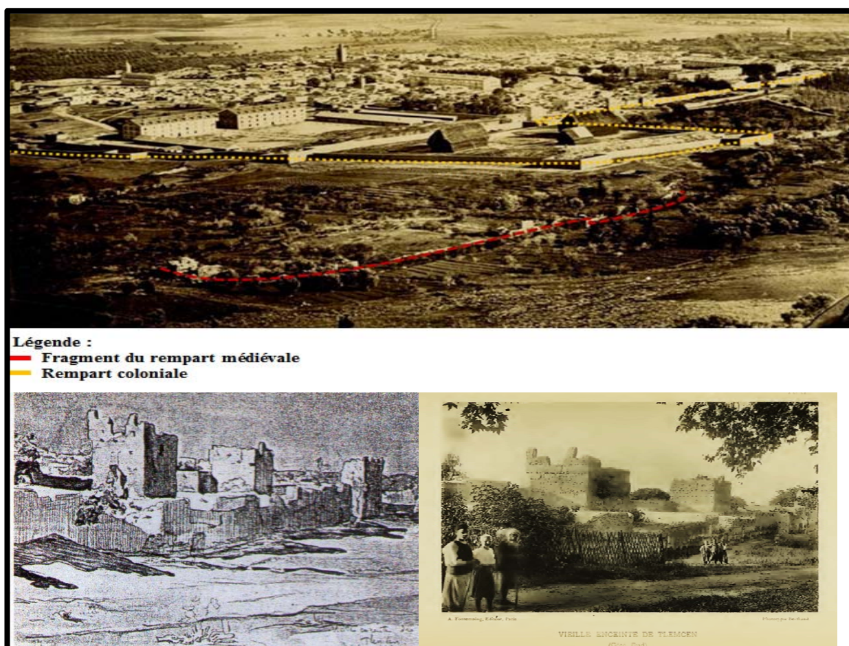
Figure 157 : Rempart de Tlemcen du côté Sud
