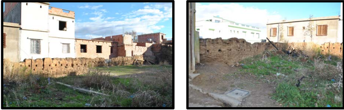
Figure 140 : Rempart en pisé du rempart ouest d'Agadir
