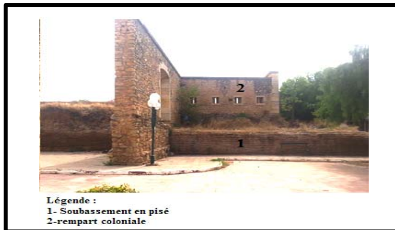
Figure 201: stratification du rempart colonial sur la paroi en pisé du grand bassin
