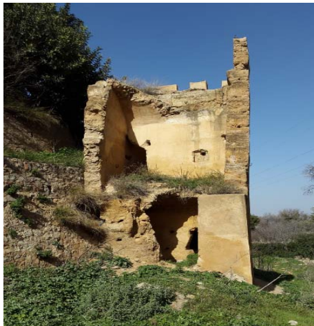
3- vue intérieure d'une tour
