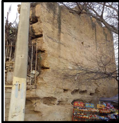
Figure 159 : Fragment d'une tour en pisé du premier avant-mur Ouest
